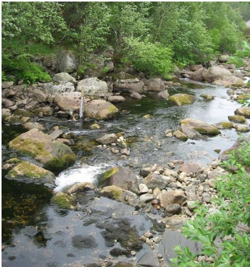
Ca. 0,02 m 3 /s målt ved øvre målestasjon. Luke stengt. Liten lekkasje fra luke. 2013 06 12.
