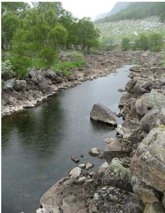
Ca. 0,02 m 3 /s målt ved øvre målestasjon. Luke stengt. Liten lekkasje fra luke. 2013 06 12.
