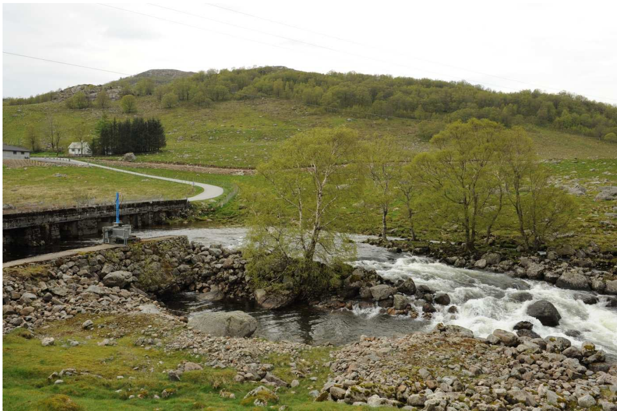
Ca. 7,3 m 3 /s målt ved øvre målestasjon. Overløp. 2012 05 21.
