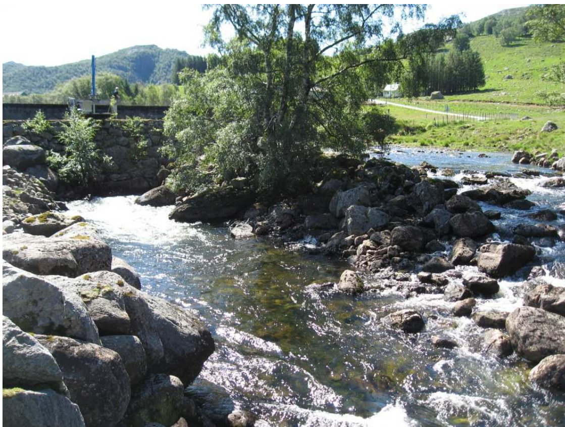
Ca. 3,3 m 3 /s målt ved øvre målestasjon. Overløp. 2013 07 24.
