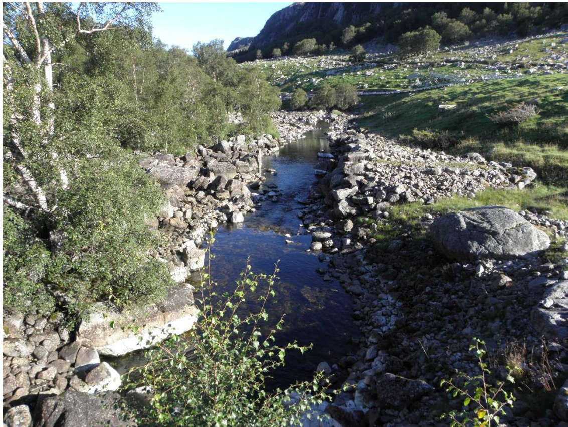
Ca. 0,22 m 3 /s sluppet fra luka. Ingen overløp. 2013 08 15.
