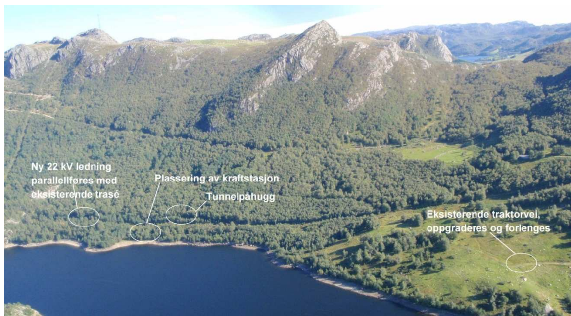
Figur 3-2 Kraftstasjonsområdet ved Oltedalsvatnet.
