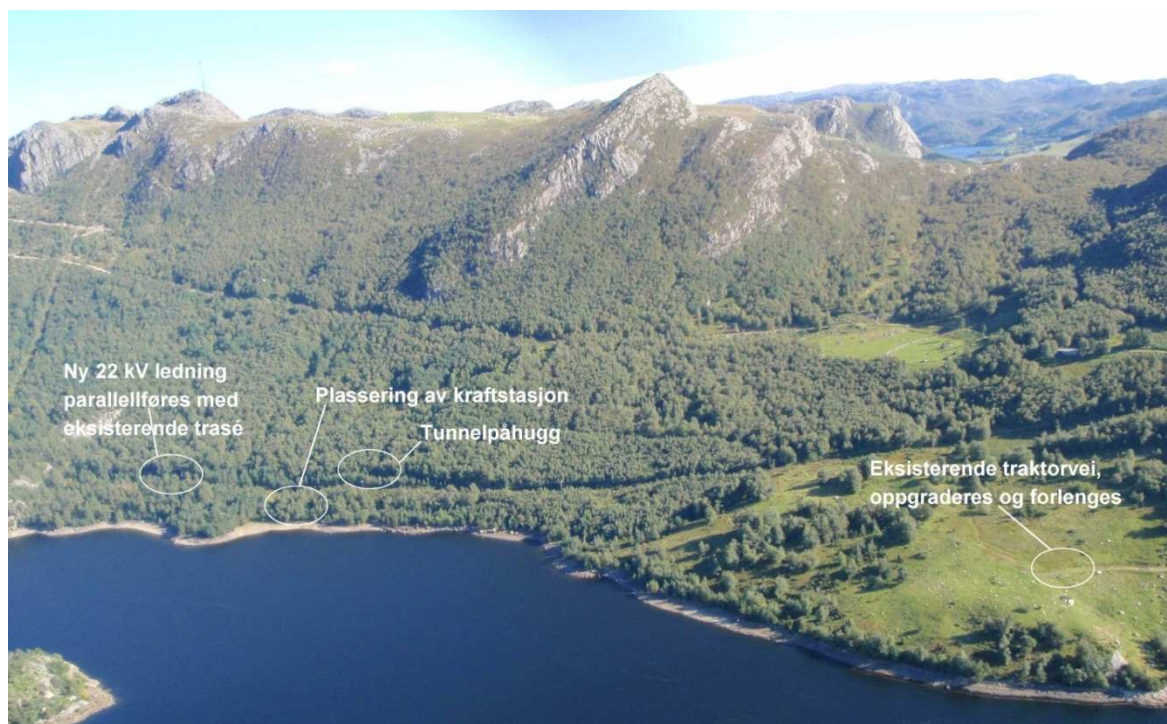
Figur 3-2 Kraftstasjonsområdet ved Oltedalsvatnet.
