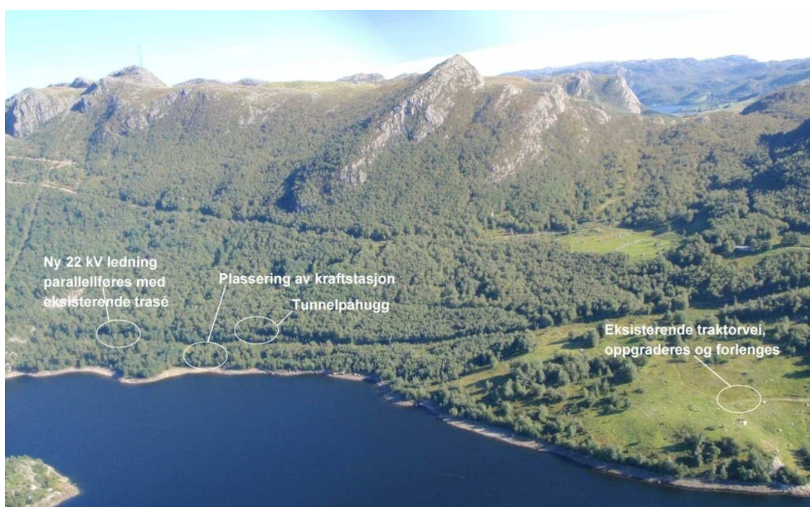
Figur 1-3 Kraftstasjonsområdet ved Oltedalsvatnet.
