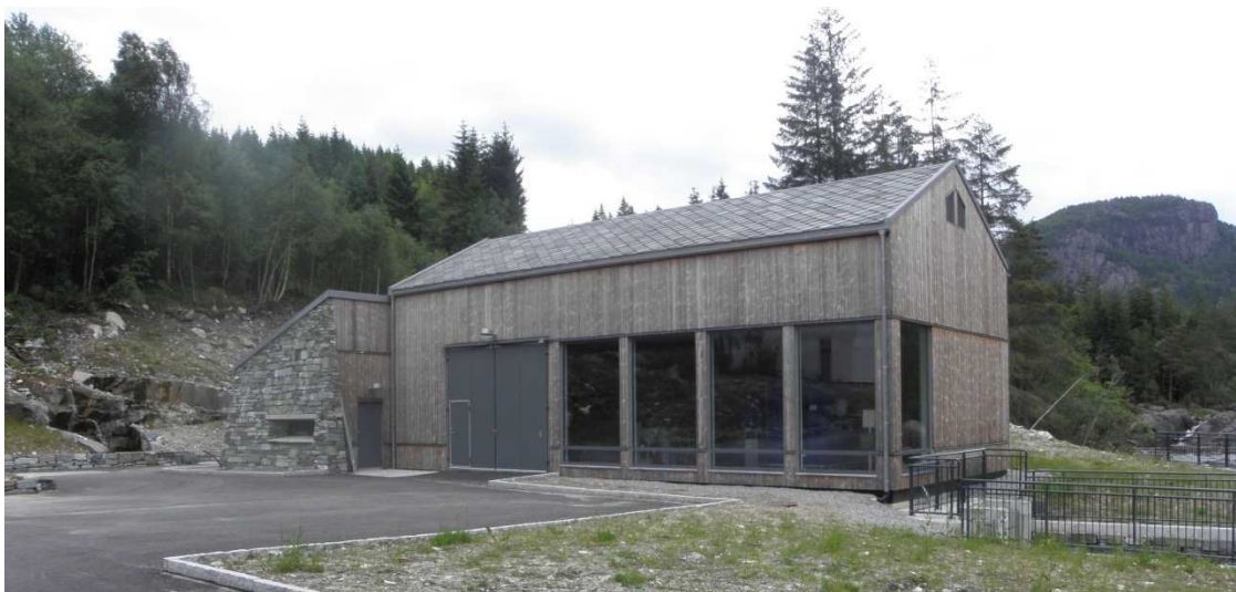
Figur 5-9 Eksempel fra Dalen I kraftstasjon (Jørpeland) på materialbruk og utforming av kraftstasjonsbygg
