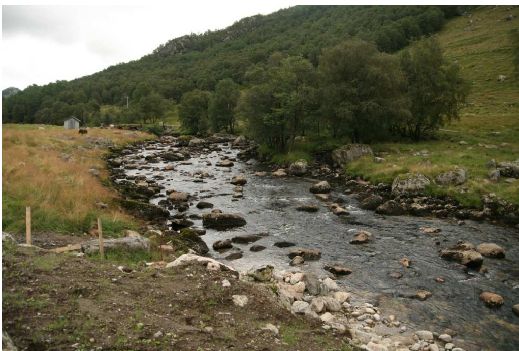
Figur 14. Ved en vannføring på 250 l/s (80 l/s mindre enn planlagt minstevannføring) ved utløpet av Madlandsvatnet (vist på bildet) synes selvgjerdeeffekten å være opprettholdt langs store deler av Madlandselva, spesielt i de øverste delene og i rasktflytende partier samt dypere kulper nedstrøms utløpet til Vølstadbekken.
