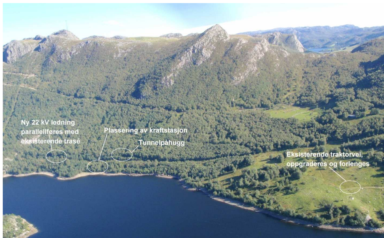
Figur 3-2 Kraftstasjonsområdet ved Oltedalsvatnet.
