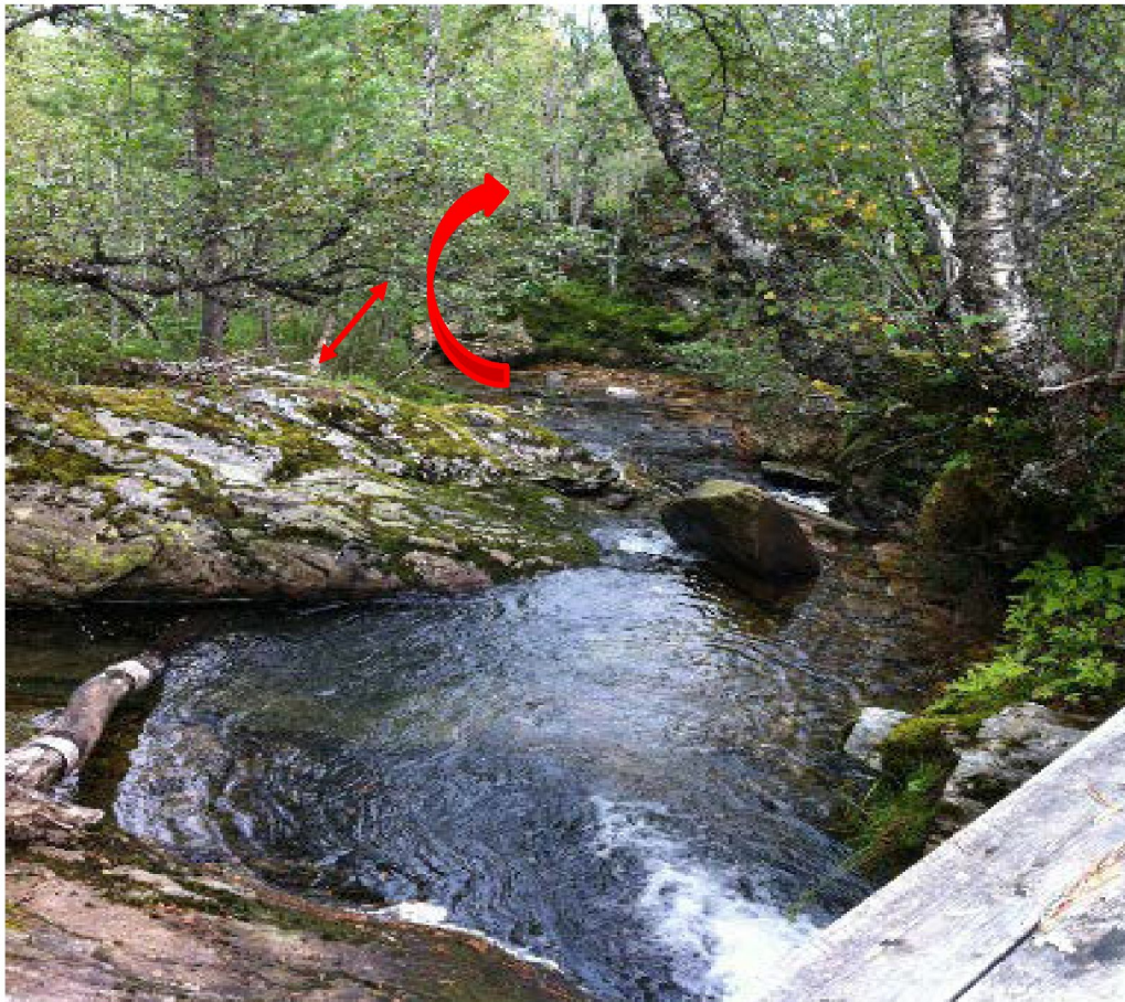
Figur 5 - 7: Bilete sett frå gangbru over Vinsandelva(kote 421) Bua pil er overføringsgrøft. Rett pil markerer sperredam. Foto: Ole Reidar Flatby
