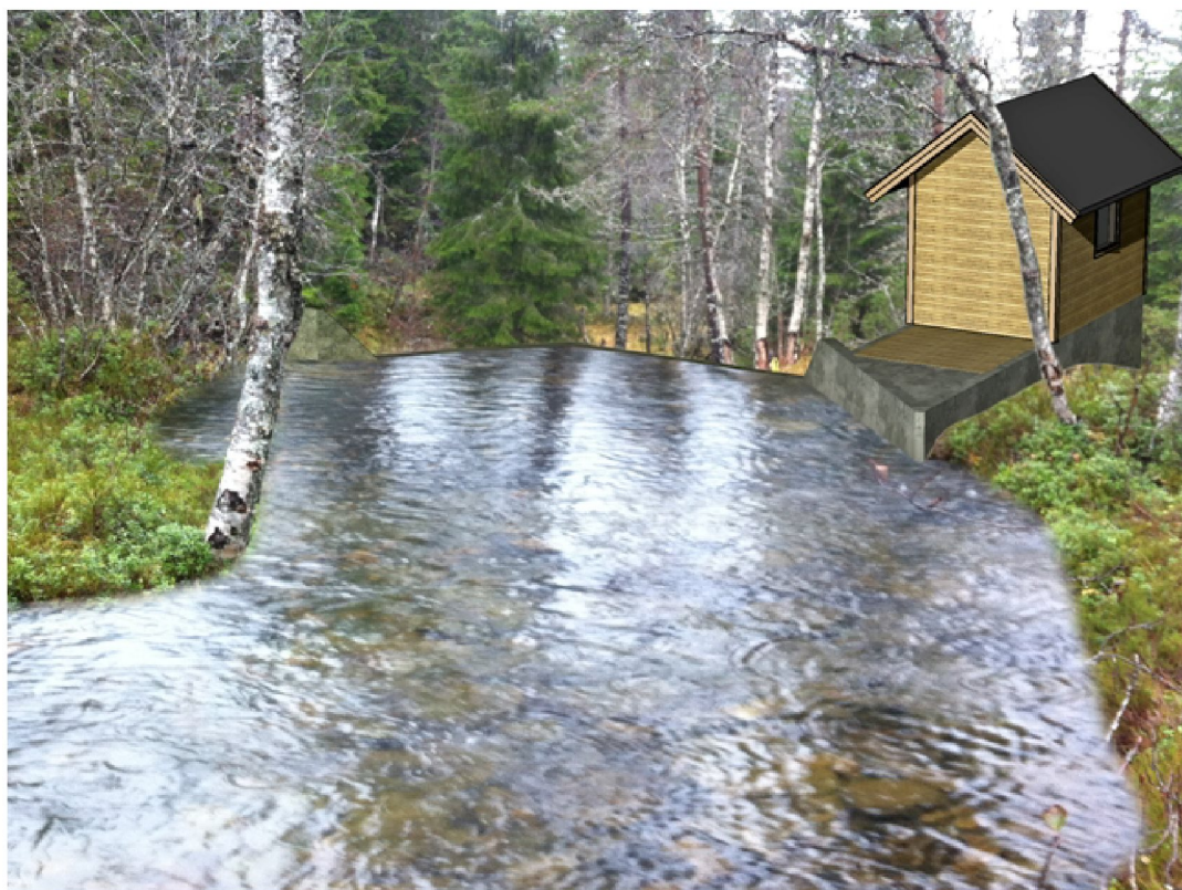
Figur 5 - 5: Visualisering av hovudinntaket i Nesthuselva, dam og lukehus. Foto: Bystøl A/S.
