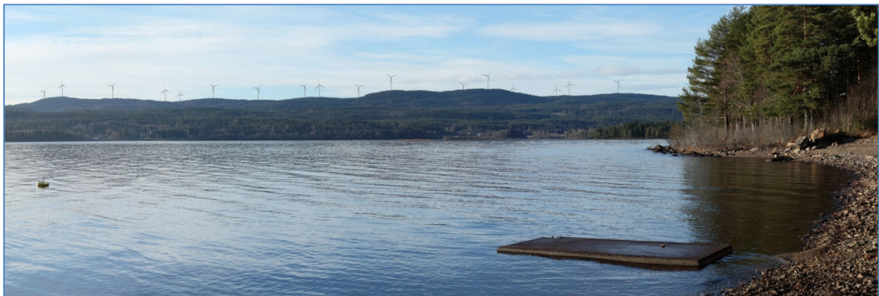
Figur 7-21. Utsnitt av visualisering av Songkjølen vindkraftverk sett fra badeplassen Bukkeneset. Ill.: Falovind.
