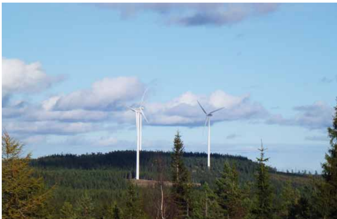
Figur 6. Eksempel på vindturbiner som kan være egnet for vindkraftprosjekt i Nord-Odal og Nes kommuner. Tårnet i aktuelle vindturbiner er cirka 90-140 meter høyt og hvert vingebled er cirka 40-60 meter langt. Fotoet viser turbiner i Fjällberget vindkraftverk, Ludvika i Sverige. Foto: Sweco.
