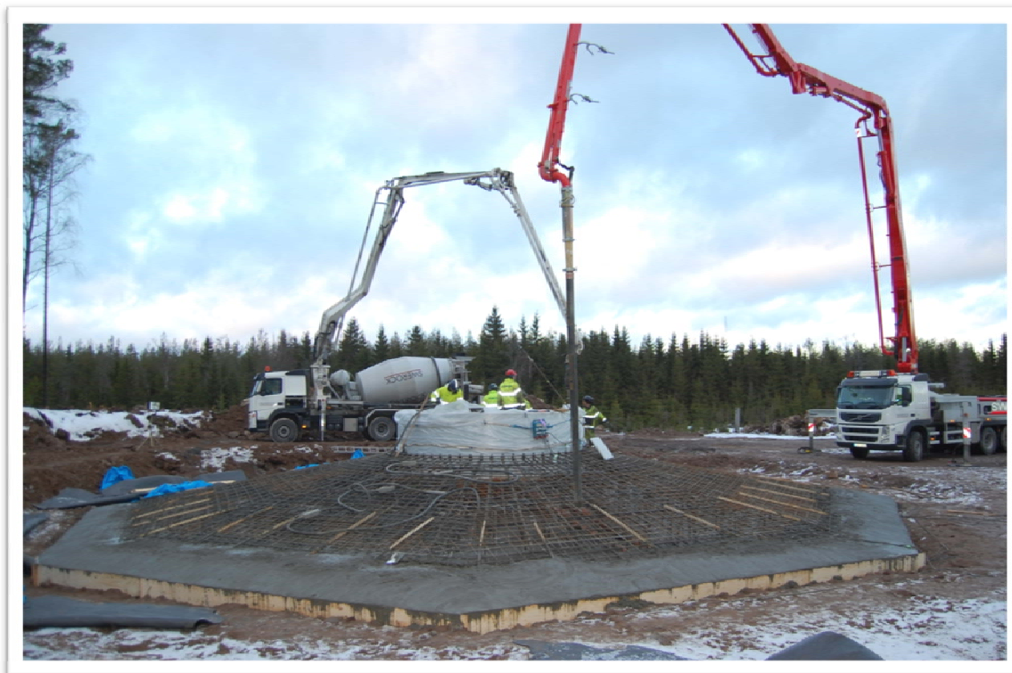
Figur 6-10 Støping av gravitasjonsfundament. Foto E.ON Vind
