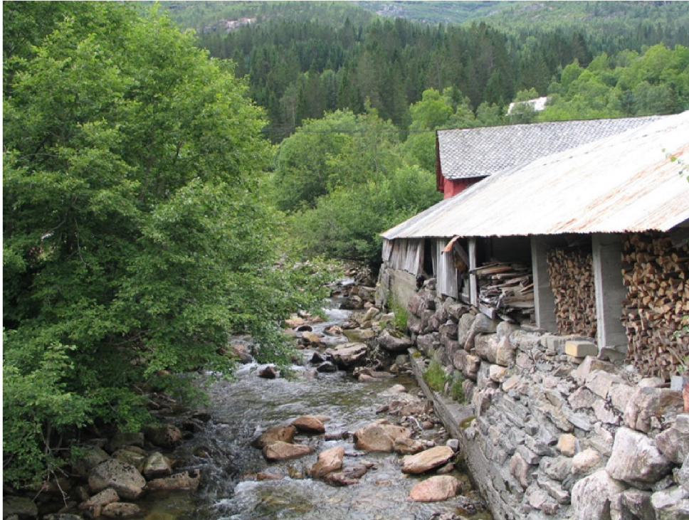
Figur 5 - 12: Nedstrøms utlaupet til Storagroe Kraft. Bilete er teke frå sør. Kraftstasjonen vil plasseras like nord for vedskjul / materiallager på austsida av elva. Foto: Nils Fatland
