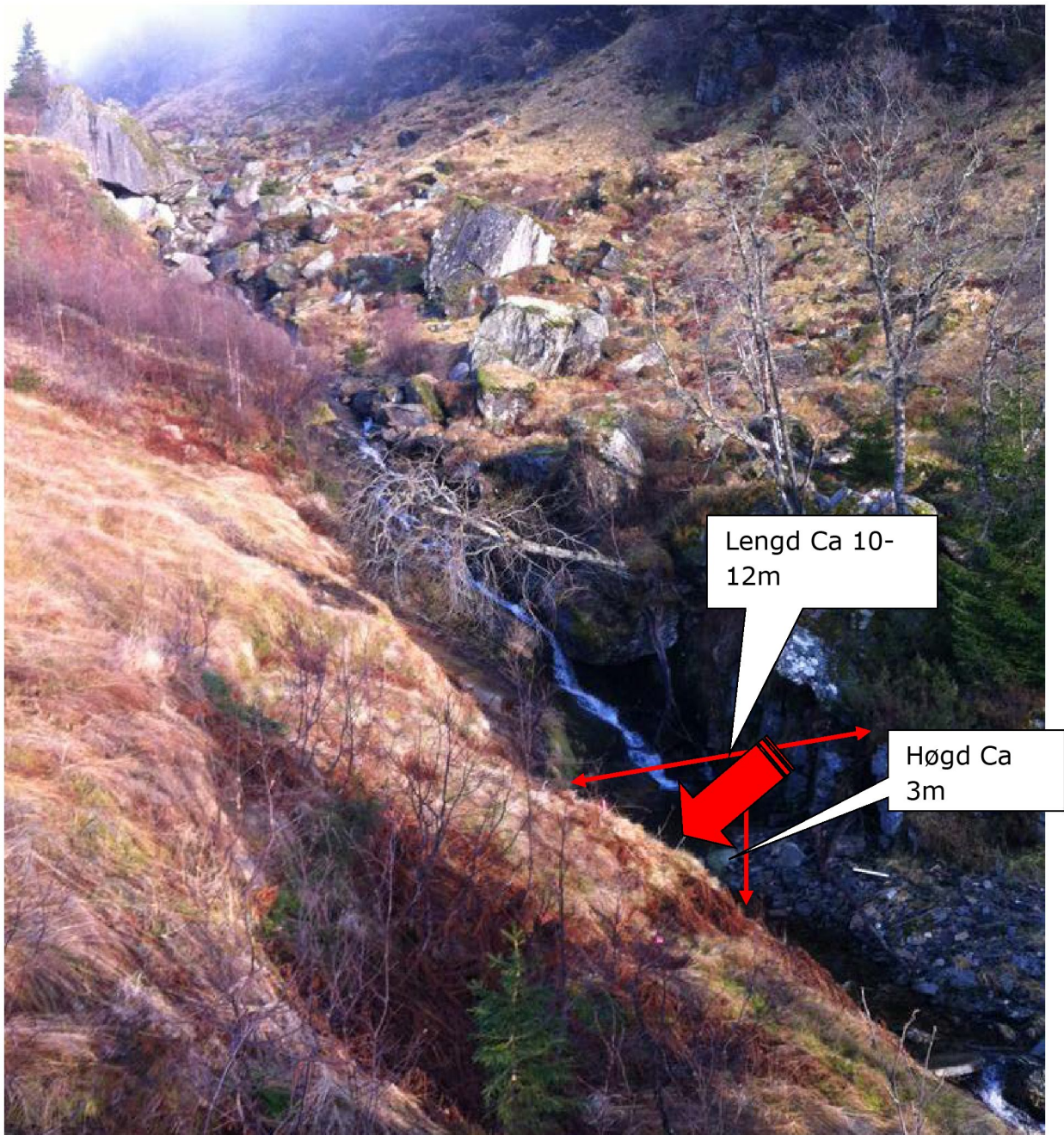
Figur 5 - 5: Bilete over området for sideinntak. Raude piler indikerer plassering av betongsperrredam mellom fjellparti og overlaup i dagens elvetrase. Grovhol for overføring vil byrja ca der grov raud pil er markert. Høgden og lengdene kan avvike litt til endeleg slutning. Foto: Ole Reidar Flatby
