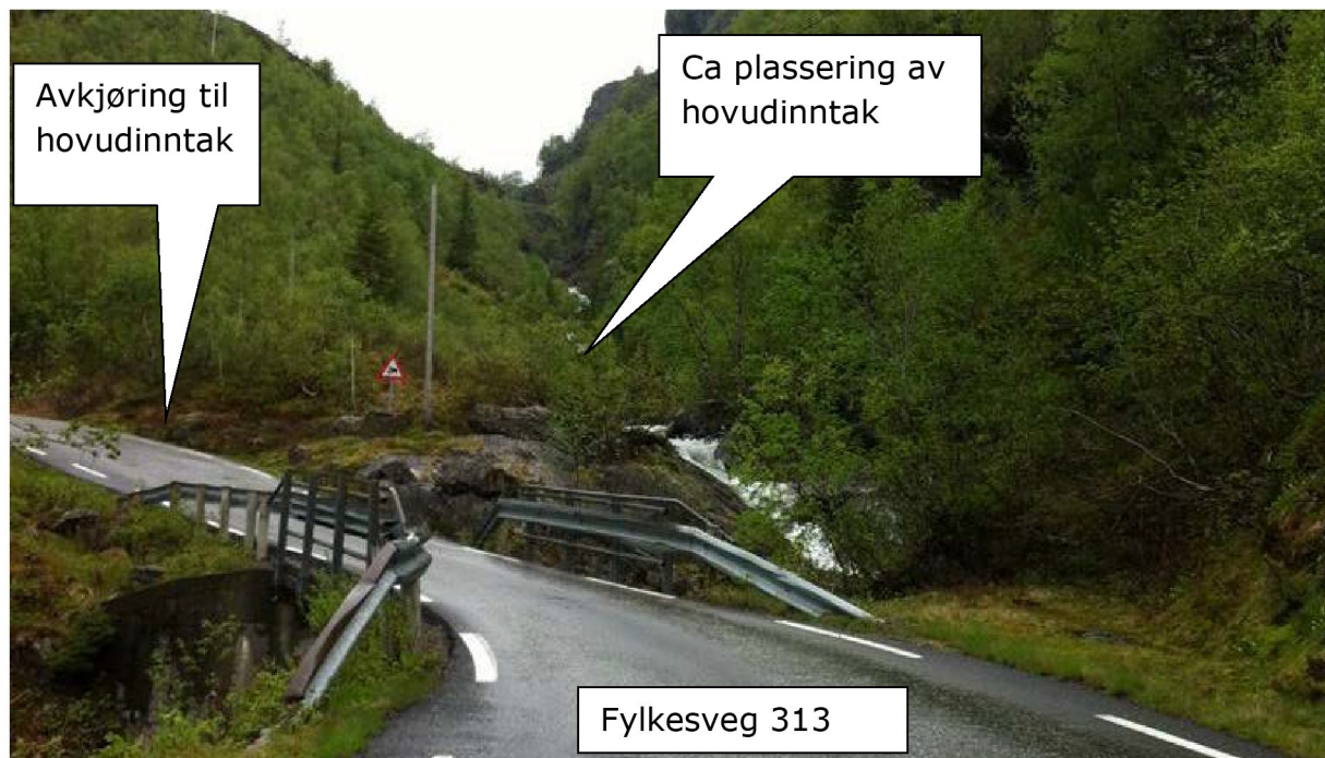
Figur 5 - 3: Bilete over inntaksområdet tatt frå sør mot nord. Inntaket i hovudelva er markert med pil. Vassvegen vil gå på venstre side av elva like ved avkjørsle til inntaket. Sjå vedlegg 3 for situasjonsplan. Foto; Ole Reidar Flatby
