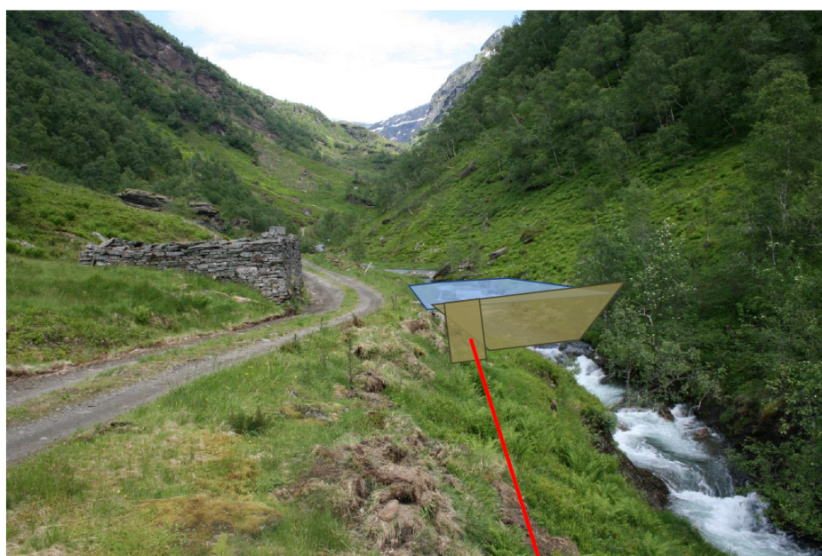
Fig. 14 Dam og inntak i Bjørndalen
