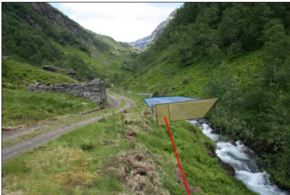
Figur 9 Dam, inntak, vannvei og oppdemt areal.
