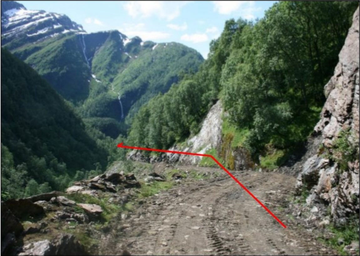
Figur 11 Rørgata legges i eksisterende vei hele veien fra inntak til kraftstasjon.
