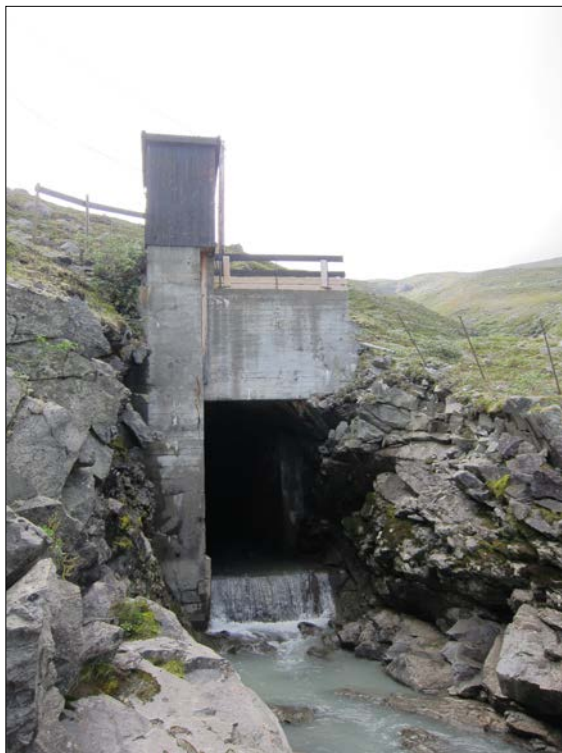
Figur 1. Inntaket til overføringstunnelen i Veo (t.v) og utløpet av overføringstunnelen i Smådalen med målehus for overført vannmengde (t.h)
