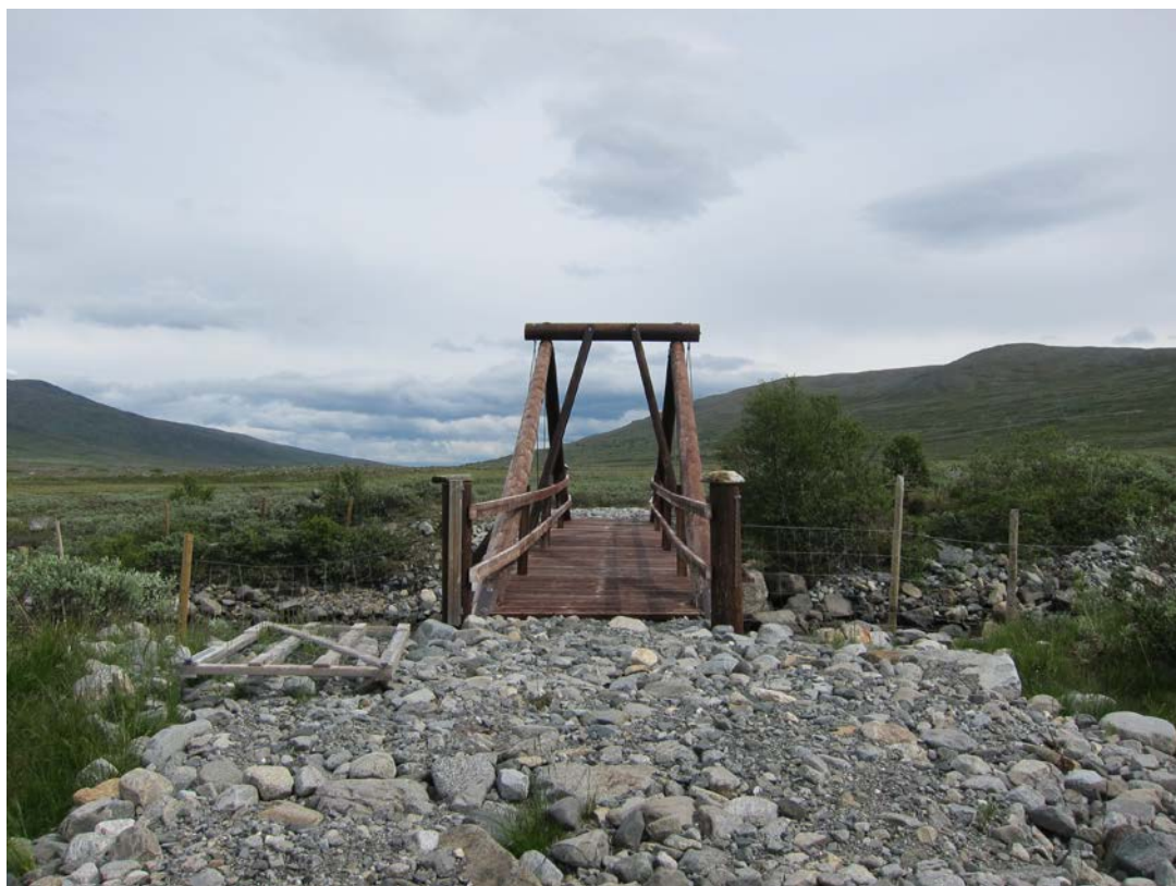
Figur 3. Gangbru over det kunstige elveløpet fra Veo-overføringen
