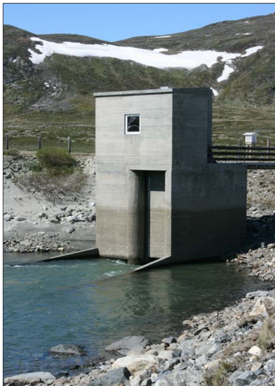
Figur 1. Inntaket til overføringstunnelen i Veo (t.v) og utløpet av overføringstunnelen i Smådalen med målehus for overført vannmengde (t.h)
