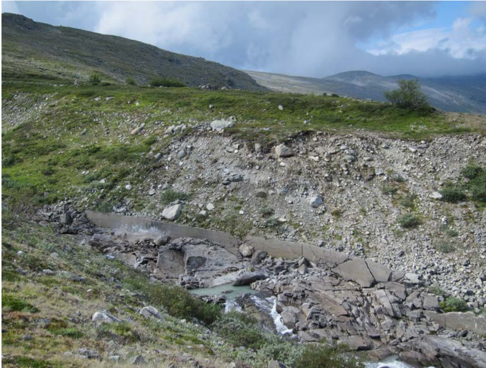
Figur 4. Elveløpet ved utløpet av overføringstunnelen hvor elva har erodert ned på fjell
