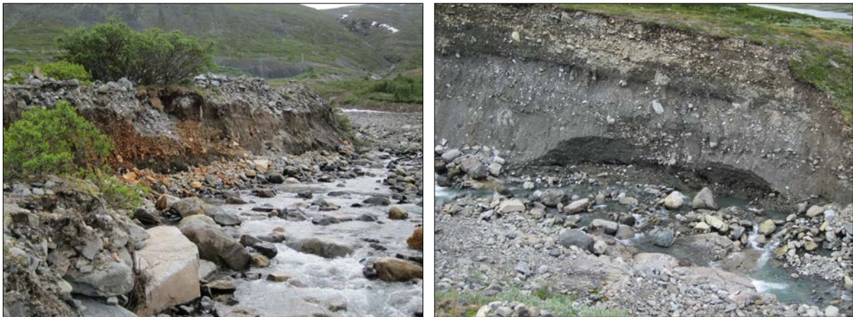
Figur 18. Aktive erosjonspunkt langs elveløpet mellom overføringstunnelen og Smådøla
