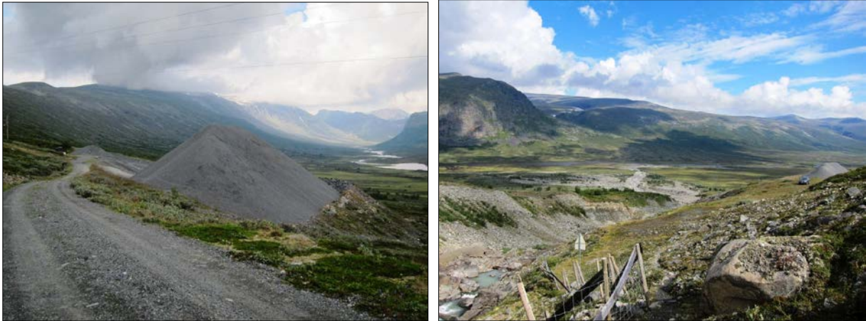
Figur 19. Oversiktsbilde over massetipp (t.v) og elveløp fra tunnelutløp (t.h) i Smådalen
