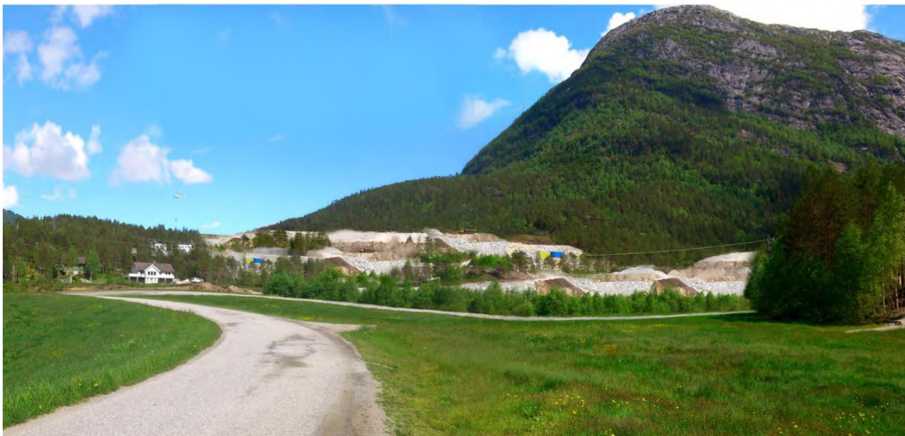
Figur 2.30 Redigert foto viser en skissert utvidelse av massedeponiet (7), samt driftsveien til adkomsttunnelen. Bildet viser situasjonen i anleggsperioden. Etter hvert vil terrenget istandsettes og gro igjen. Skog vil plantes og vokse til slik at deponiet vil bli en integrert del av landskapet omkring.
