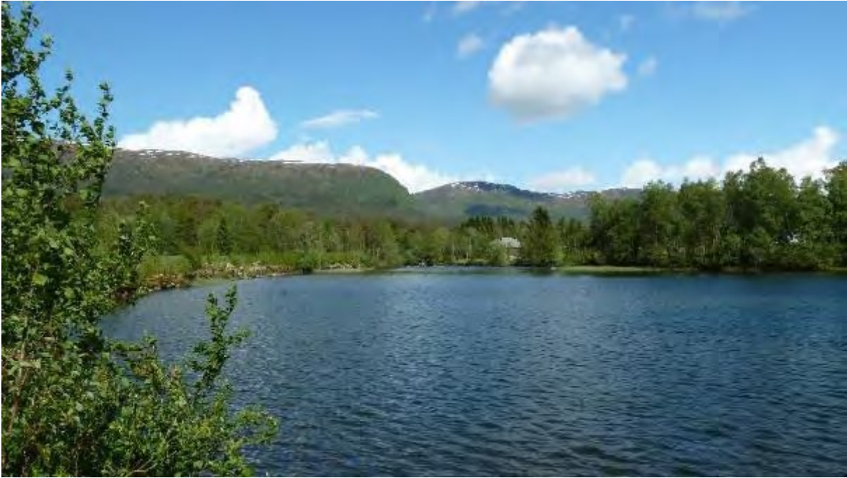
Figur 10. Inntaksområdet for Jølstra kraftverk i Tongahølen. Restar etter Kvamsfossen kraftverk som var i drift frå 1946 til 1962 ligg på sørsida av Kvamsfossen. Kanalen (vassvegen) til Kvamsfossen kraftverk kan sjåast til venstre for Kvamsfossen lengst bak i bildet.
