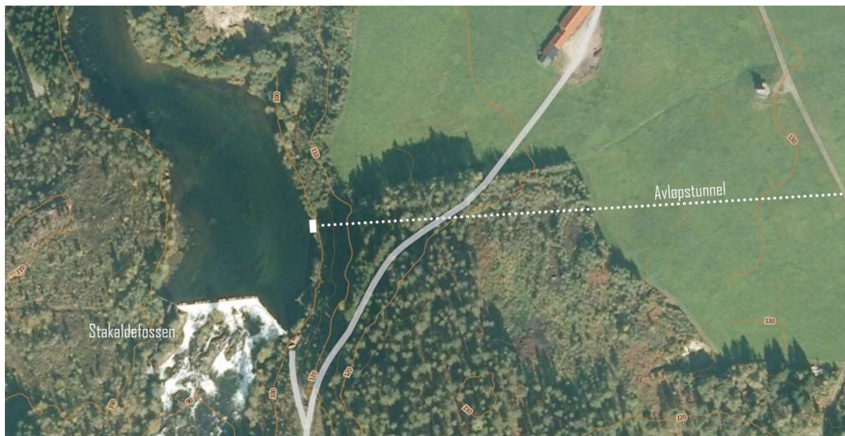
Figur 2.27 Flyfotoet viser plassering av avløpstunnelen nord for Stakaldefossen.
