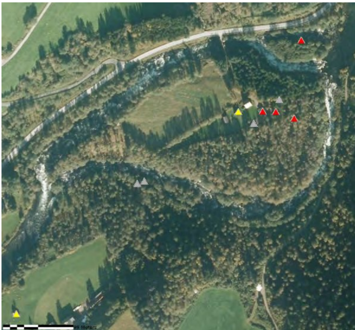
Figur 13. Kulturmiljø 2 Øyna. Gardstunet på Øyna ligg sentralt på ei større øy i Jølstra. Kvernhuset på Kvennhusøyna (holme i elva ved Kvamshølen) øvst i biletet er restaurert. Husmannsplassen på Slåtten nedst i biletet.
