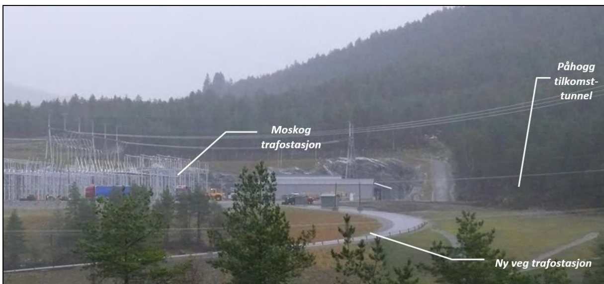
Figur 3. Påhogg for atkomsttunnel blir like ved Moskog transformatorstasjon. Foto: Norconsult AS.
