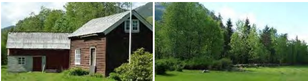
Figur 17. Bygningsmiljøet og kulturlandskapet på Øyna.
