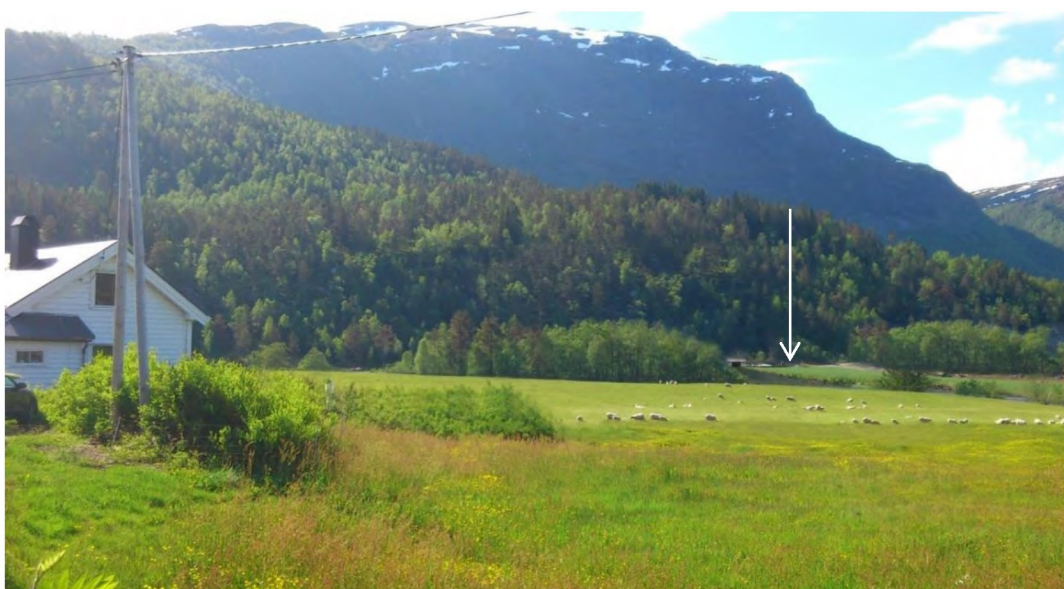
Figur 2.10 Redigert foto. Det er anlagt massedeponi (2) på terrenget mellom gården og Tongahølen, så dette er hevet noe. Vannstanden i hølen er hevet med ca. 1 meter men mindre synlig pga. massedeponi 2.. Det er etablert et inntak i Tongahølen, der vannet er ført i kanal inn mot tunnelpåhugget. Eksisterende masseuttak (1) er fylt igjen med masse fra tunnelene og har grodd igjen.
