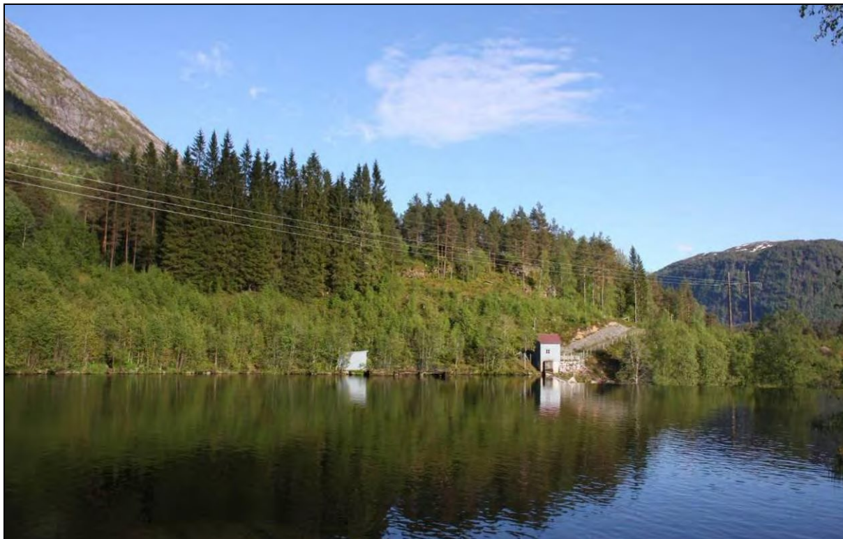
Figur 8. Frå kraftverket leiast vatnet tilbake til Jølstra i inntaksbassenget for Stakaldefossen kraftverk, kote 99.
