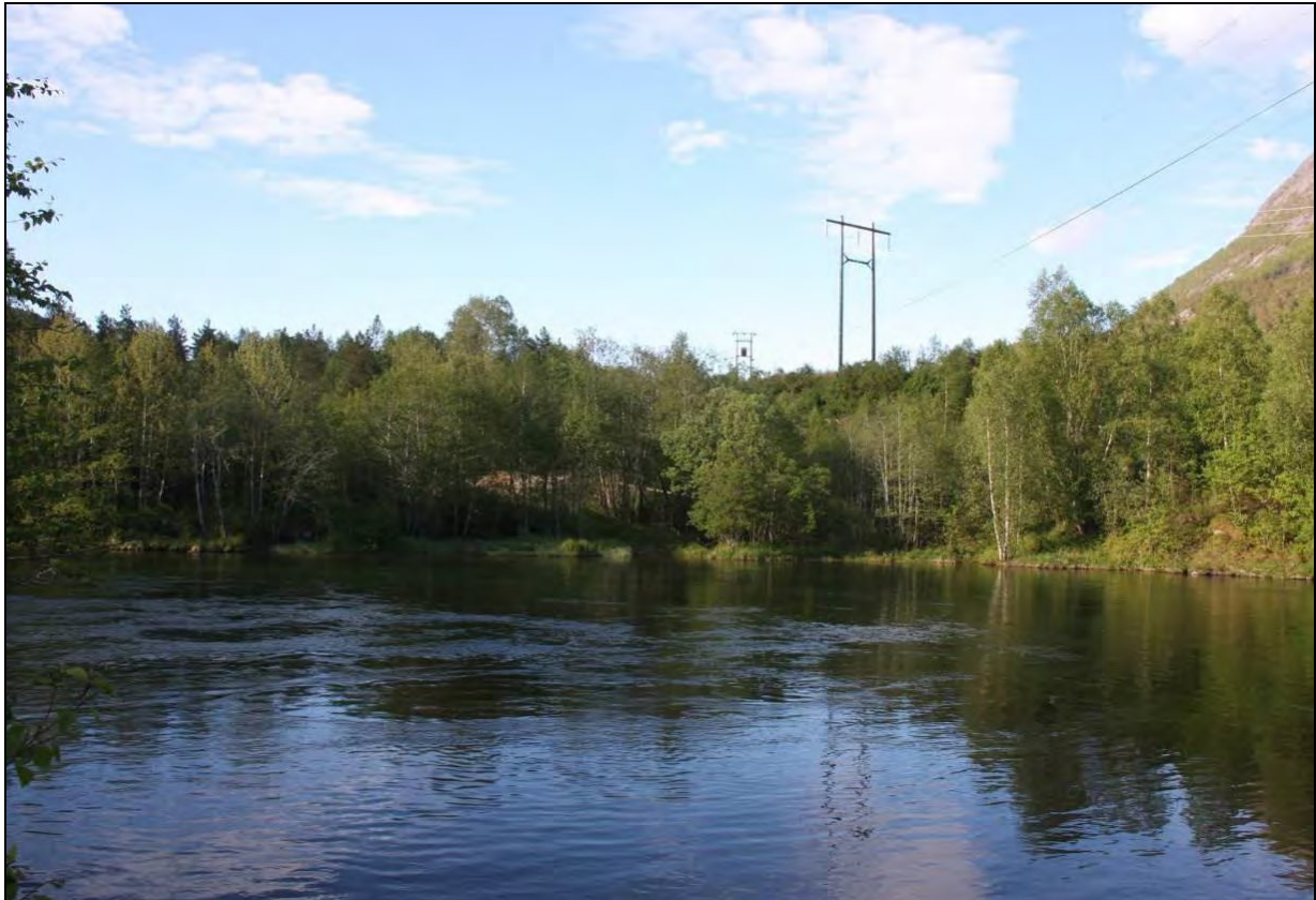
Figur 14. Deponi 6: Nord for inntaksbassenget for Stakaldefossen kraftverk finst eit lite massetak, Grimsbøen 1, som er mogeleg deponi for tunnelmassar.
