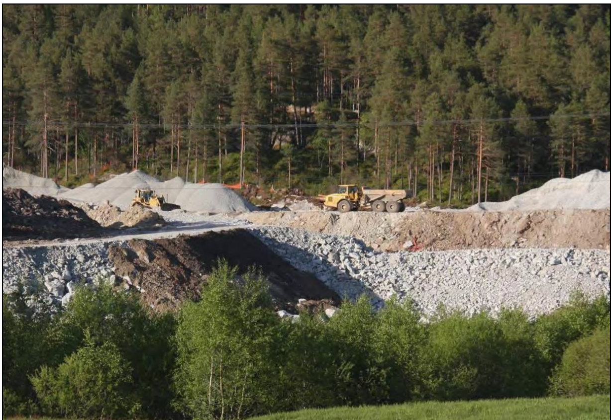
Figur 15. Deponi 7: Mogleg massedeponi Grimsbøen 2, kor Statnett byggjer ny transformatorstasjon.
