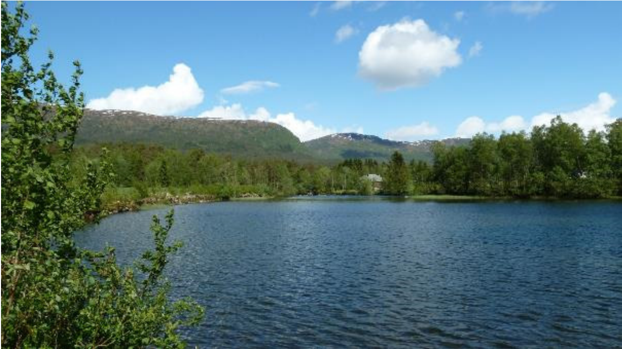
Figur 10. Inntaksområdet for Jølstra kraftverk i Tongahølen. Restar etter Kvamsfossen kraftverk som var i drift frå 1946 til 1962 ligg på sørsida av Kvamsfossen. Kanalen (vassvegen) til Kvamsfossen kraftverk kan sjåast til venstre for Kvamsfossen lengst bak i biletet.
