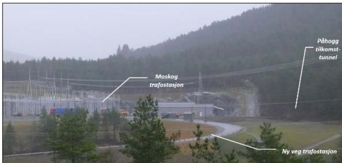
Figur 3. Påhogg for tilkomsttunnel vert like ved Moskog trafo-stasjon.
