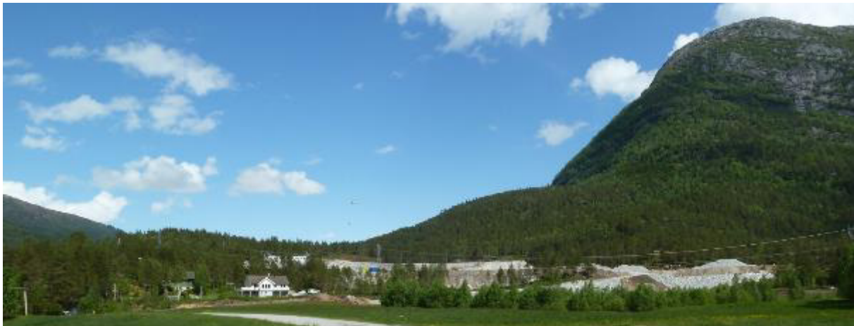
Figur 30. Delar av kulturmiljø 7 Moskog. Statnett sitt transformatorstasjonsområde under bygging ovanfor framtidig industriområde.
