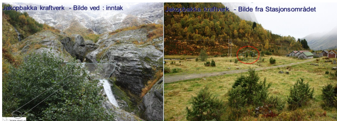
Figur 5: Illustrasjon av inntaket og kraftstasjonen
