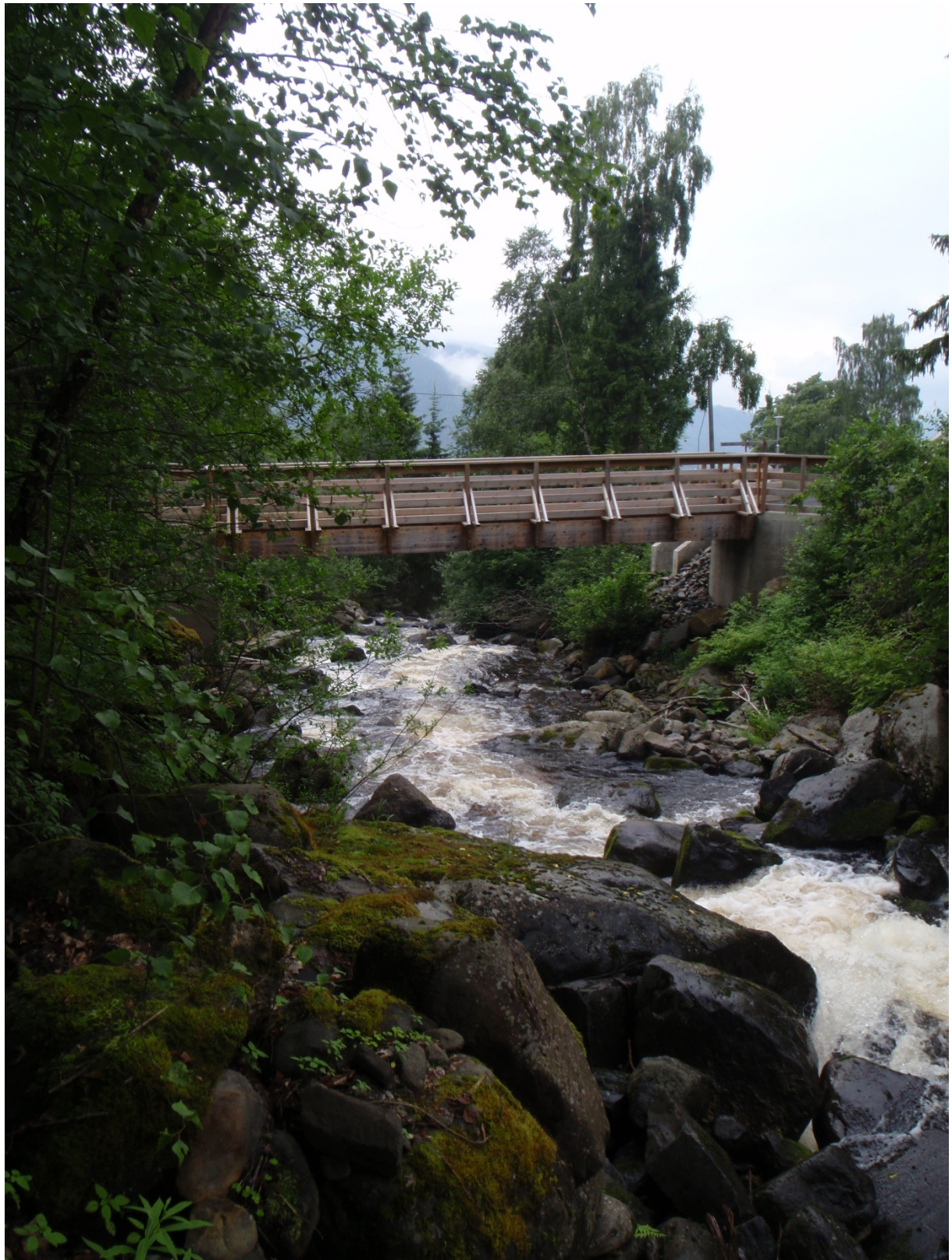
Bilde 16 Mosåa ved skibrua 200-300 m oppstrøms planlagt kraftstasjon. Bilde tatt 05.07.2011 og vannføring 0,1 \text{ m}^3/\text{s} skalert fra 2.323 Fura (sannsynligvis er vannføringen større).
