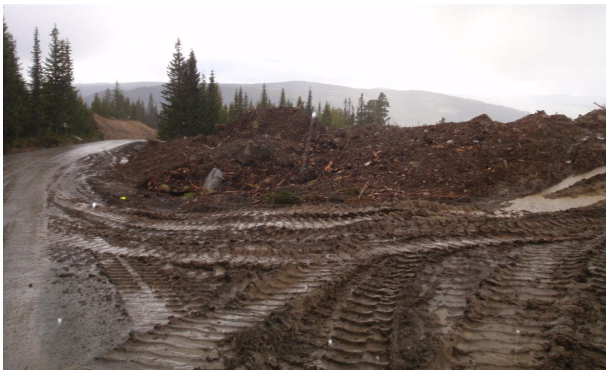
Bilde 6 Rørgata går til høyre i bildet, mellom vegen og overkant av steinbruddet
