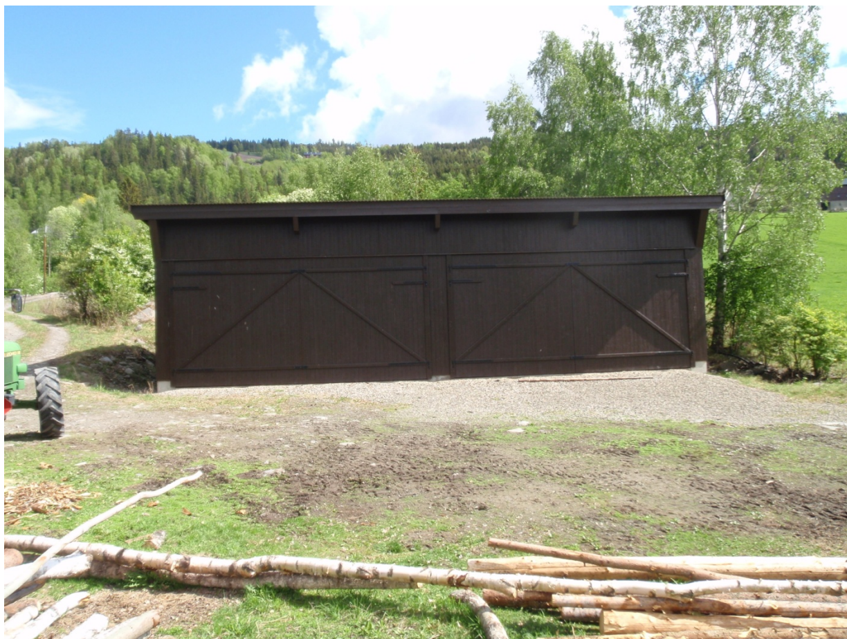
Bilde 12 Eksisterende bygg ved kraftstasjon. Området er opparbeidet som lagerplass
