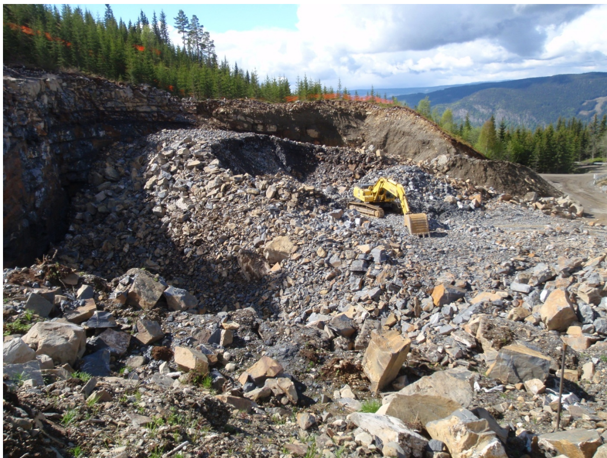
Bilde 5 Rørgata legges like i overkant av steinbruddet (fra venstre mot høyre i bildet)
