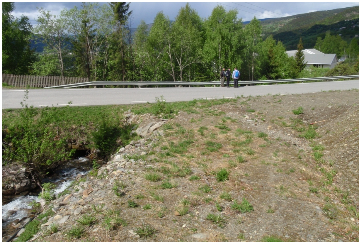
Bilde 10 Kryssing av FV 361
