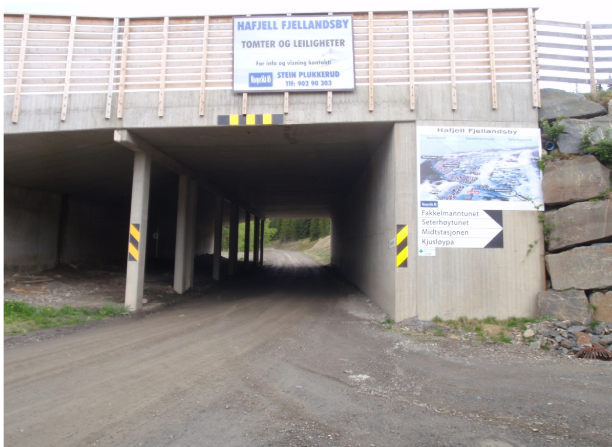
Bilde 17 Adkomstvei mellom kraftstasjon og inntak
