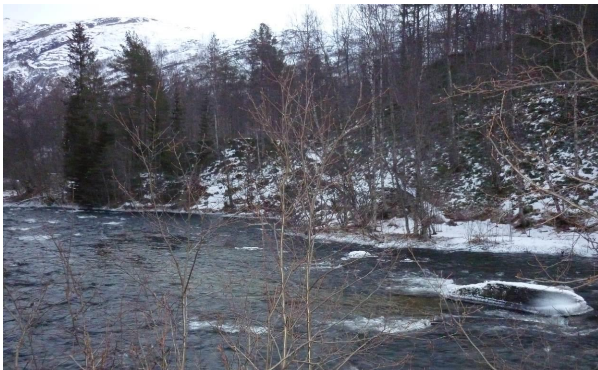
Bilde 12 Utløp fra kraftstasjon sett fra motsatt elvebredd.
