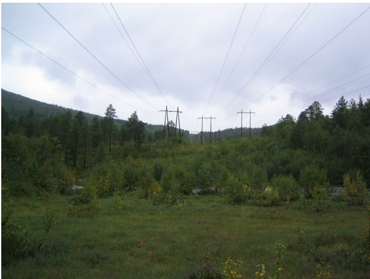
Bilde 5 66 kV kraftlinje som krysser Hoffmannselva. Sett vestover. Tipp anlegges i fotografens posisjon.
