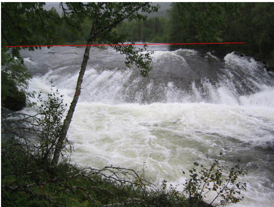
Bilde 8 Fossen rett nedstrøms dammen. Bru over Hoffmannselva skimtes i øvre midtre bildekant. Damakse er merket med rød strek.
