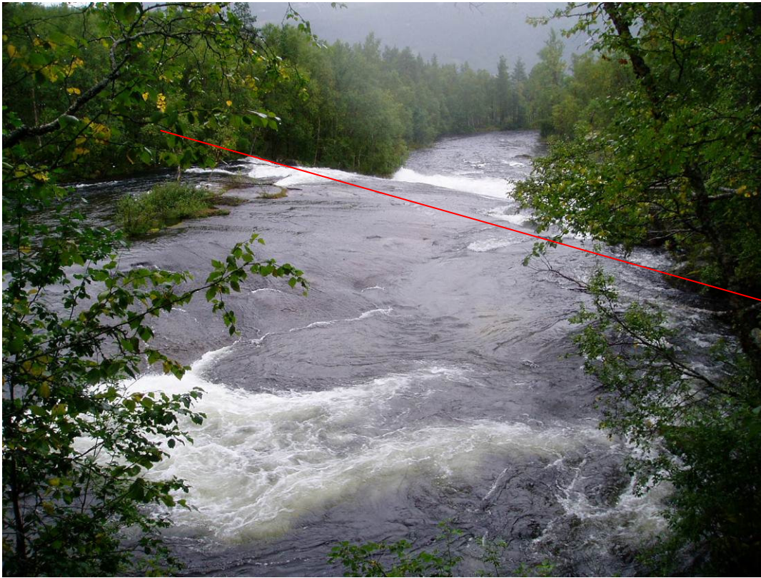
Bilde 7 Inntak og damområde sett medstrøms. Dammen kommer på tvers av elva noen meter oppstrøms fossenakken (merket med rød strek). Inntaket kommer i vika i nedre og høyre bildekant.
