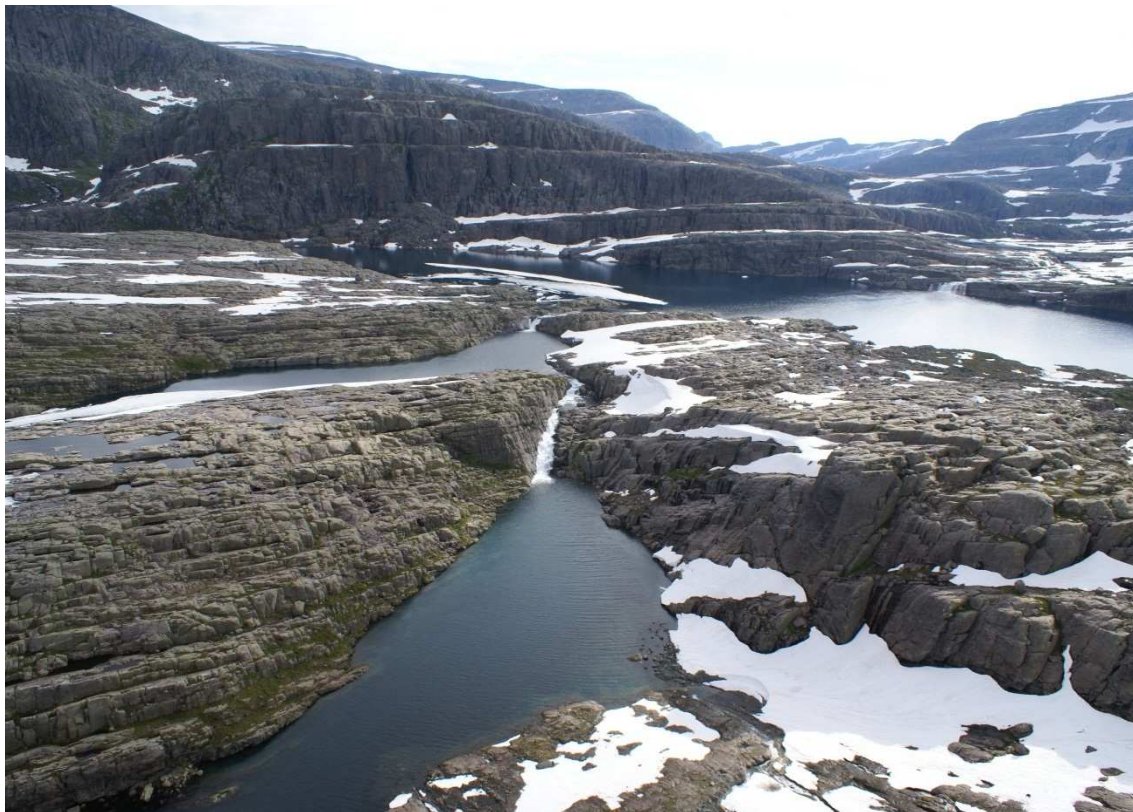
Foto 8 Dei to fossane mellom Øvre og Nedre Bredvatn frå helikopter 15.08.2012. Vassføring om lag 5,1 \text{ m}^3/\text{s} inkludert overløp frå X-vatn. Samla overføring på tidspunktet er om lag 2,5 \text{ m}^3/\text{s} .
