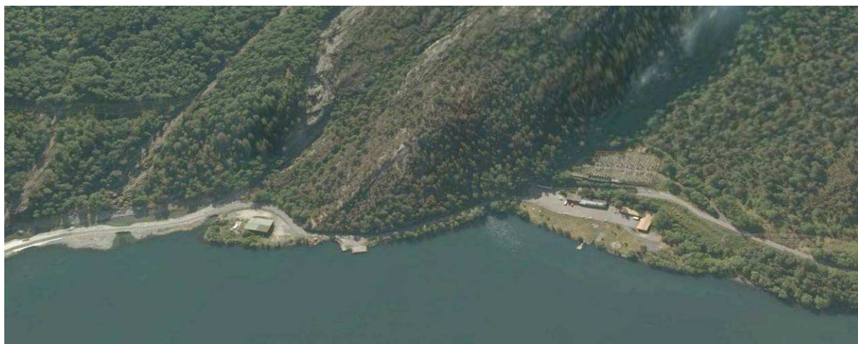
Figur 2-4 I sjøkanten i venstre del av bilete ligg eksisterande tipp med lagerbygningar. I høgre del av bilete ligg eksisterande koplingsstasjon, dagbygg og parkeringsplass for Åskåra kraftverk delvis bygd på tipp i fjorden.
