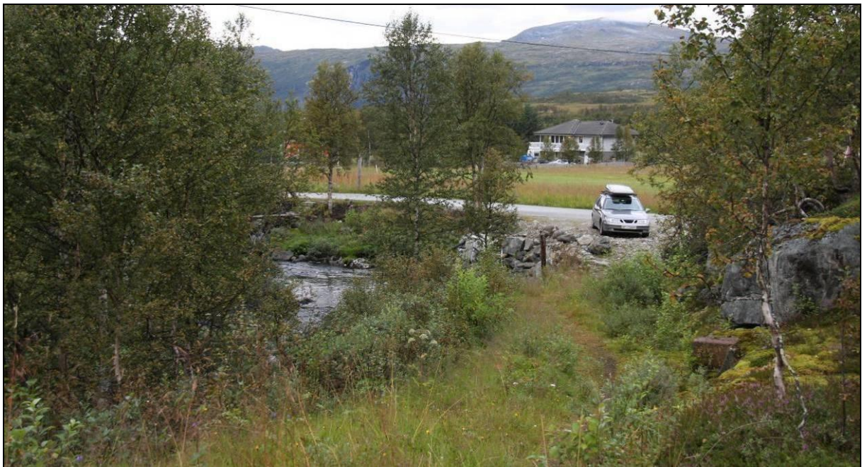
Figur 36. Nettilknytningen for Drøllstølsbekken kraftverk vil skje i form av nedgravd jordkabel langs veier og ruderatmark. Bildet er tatt mot nord fra kraftstasjonstomta. Foto: Ole Kristian Spikkeland.
