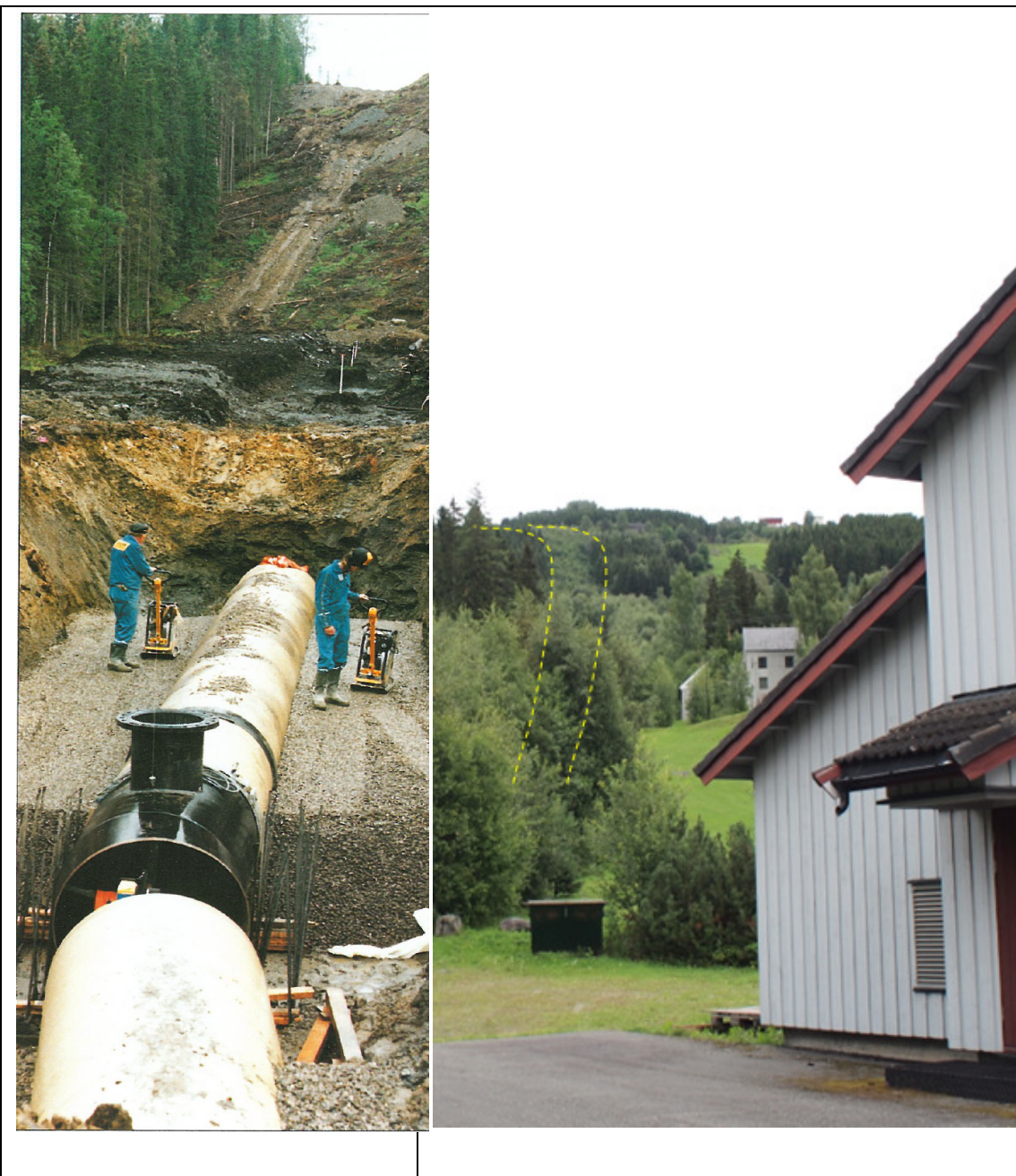
Figur 19 Til venstre, legging GRP-Rør for Mokså kraftverk 1989. Til høyre rørtraseen (gul stiplet) sett fra stasjonsområdet 2011. (Foto GE og Sweco)
