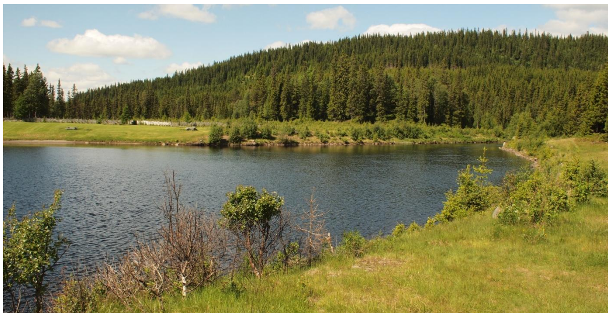
Figur 7. Eksisterende inntaksdam i Moksa. Åkvisla kraftstasjon er planlagt der elva renner inn i dammen til høyre i bildet. På motsatt bredd et inngjerdet friluftsområde der det er satt ut benker.
