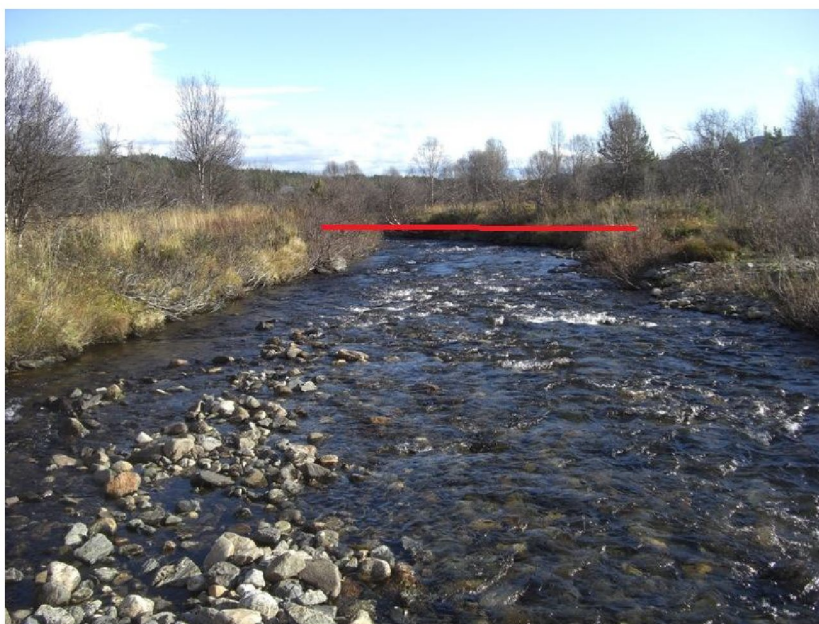
Bilde 1: Fra inntaksområdet. Demning nederst i bildet. Foto: Elvekraft.
