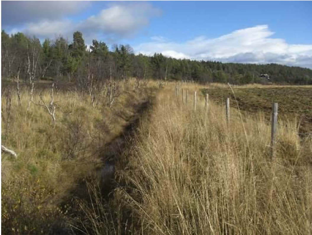
Bilde 5: Rørtrasé nedstrøms dam. Foto: Elvekraft.
