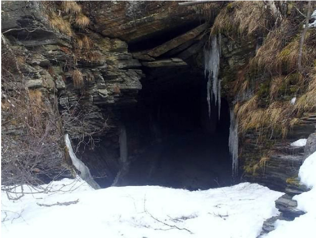
Bilde 23: Tunnelinngang under Rv 255. H= 4 m, bredde= 3 m. Foto: Arvid Lagestuen.
