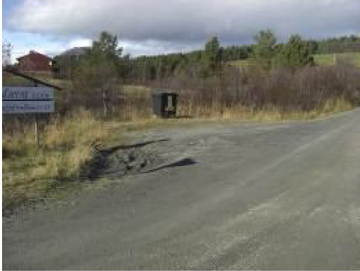
Bilde 13: Trasé sett fra riksvei og oppover. Foto: Elvekraft.
