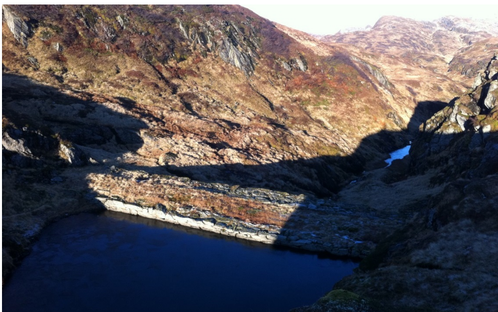
Dammen øst i Klenavatnet fjernes. HRV senkes med ca. 2-3 m og bekken fra Klenavatnet mot Herfangen reetableres.
