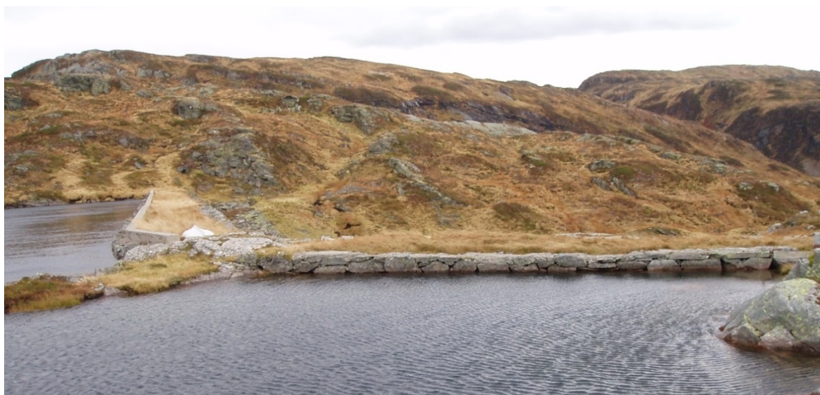
Utløp Flatavatnet mot Herfangsvatnet (se også bilde ovenfor). Høyre dam skal fjernes.
