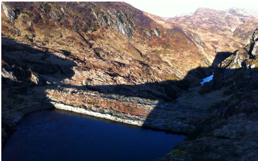
Figur 8 Klenavatnet dam som er planlagt fjerna. Sett mot Herfangen.
