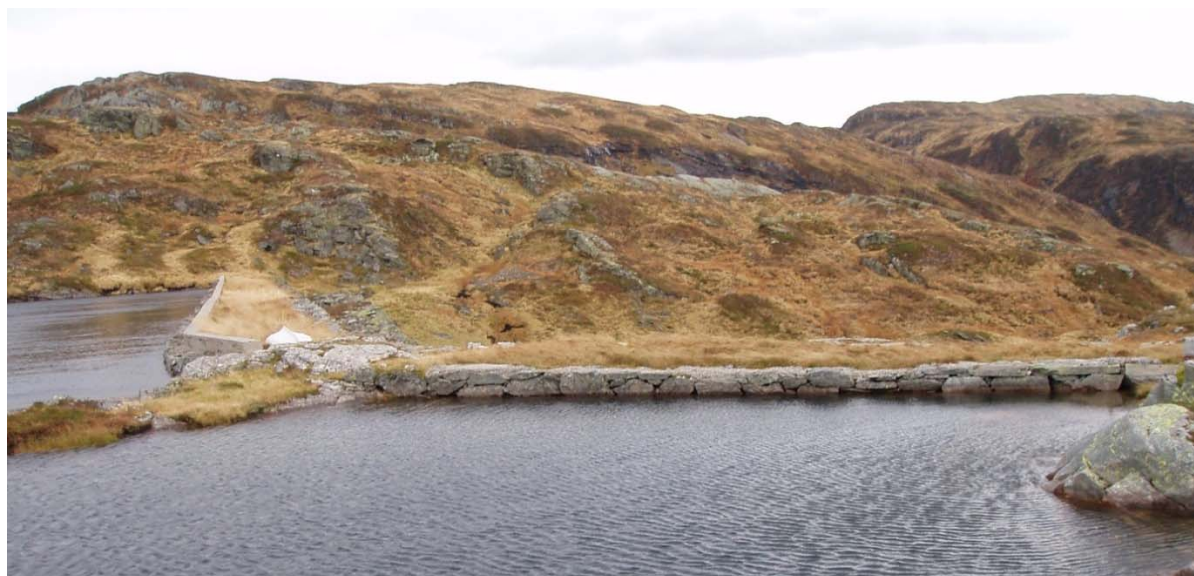
Figur 2 Flatavatnet dammar mot Herfangen. Den nærmast i bildet vert fjerna.
