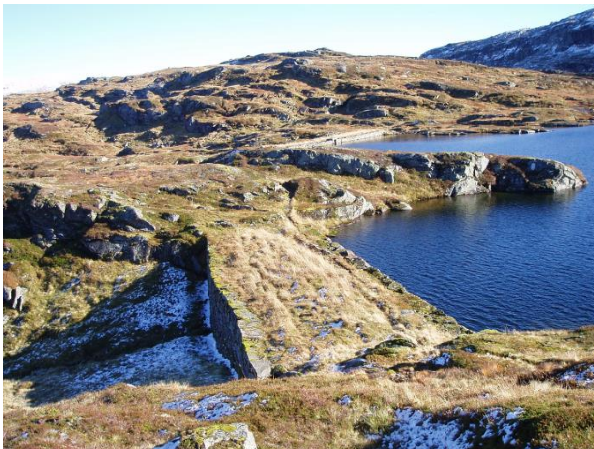
Figur 12 Sperredam og hovuddam Smørtjørna, med overløpet lengst vekk i bildet.
