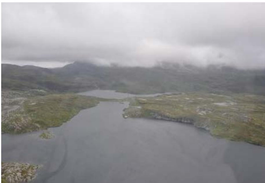
Figur 9-8. Flatavatnet mot Herfangsvatnet. Høyre demning skal fjernes og vann føres via bekk til Herfangsvatnet. Foto: BKK
