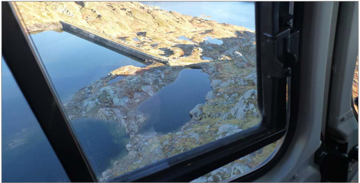
Fotoet viser nordøstre ende av Flatavatnet. Fotoet er tatt på NVE sluttbefaringen den 14. oktober 2014. Det ble vurdert at vannstanden var ca. 2,30 meter under høyeste regulerte vannstand den dagen. Foto: BKK.
