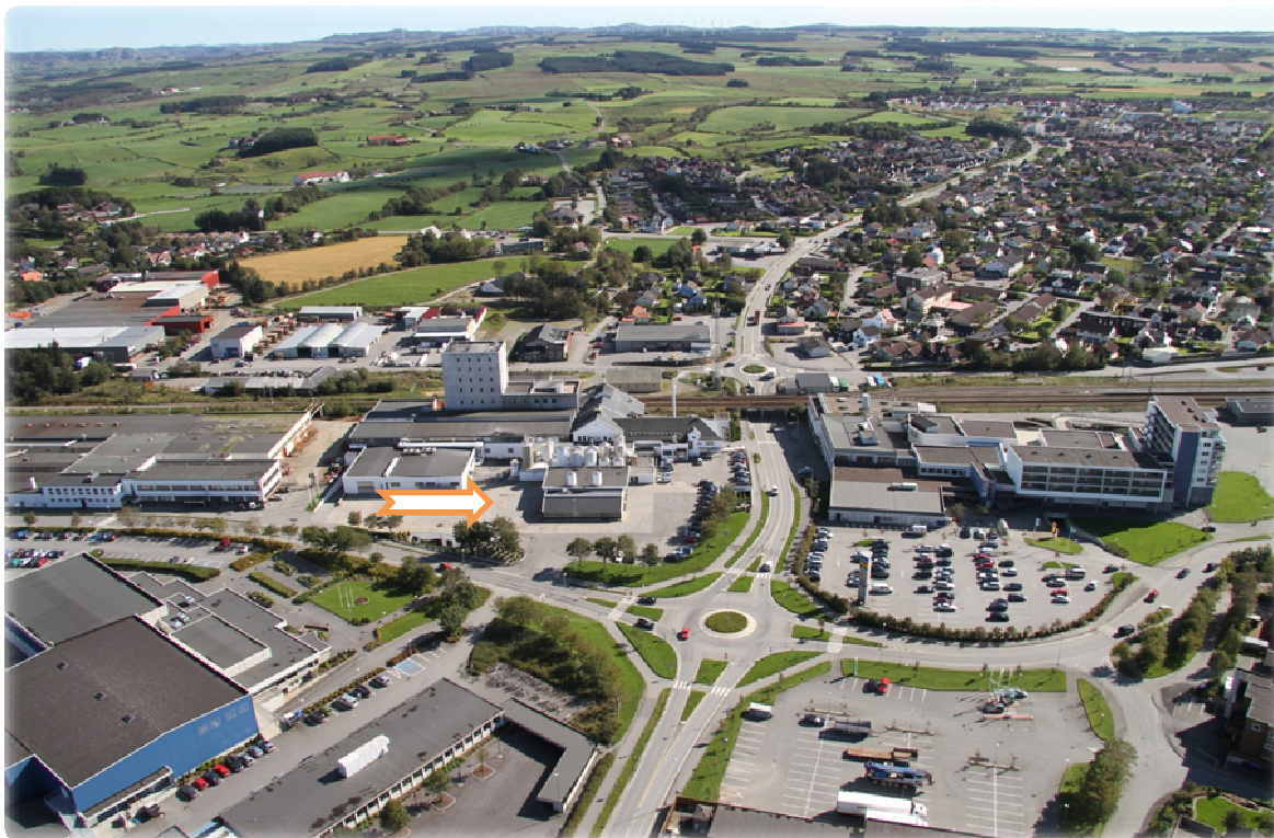
Fig 6. TINE MEIERET SØR – NÆRBØ SENTRUM Pilen viser bygg gammel varmesentral og kjølesentral med Nye Loen i forgrunnen.(foto: K2)
