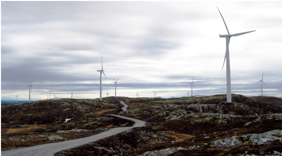
Figur 4. Eksempel på vindturbiner som kan være egnet for vindkraftprosjektet i Meråker kommune. Tårnet i aktuelle vindturbiner er cirka 80-140 meter høyt og hvert vingebled er cirka 40-60 meter langt. Fotoet viser turbiner i Hitra vindkraftverk. Foto: Sweco.
