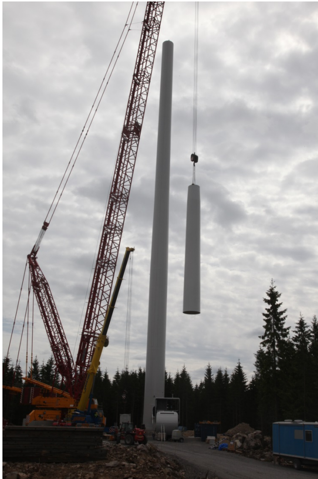
Figur 13 Montering av vindturbin.
