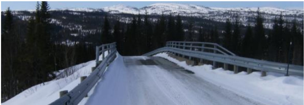
Figur 23: Bro over jernbane (bilde tatt mot sør)
