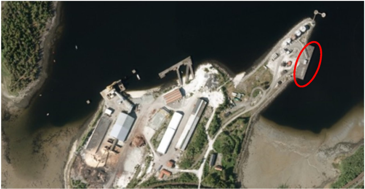
Figur 7: Havneanlegg i Muruvika
