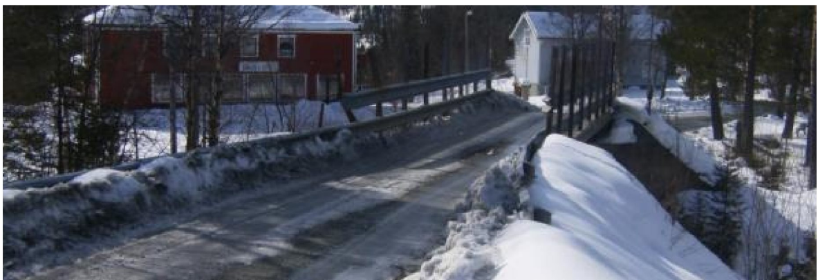
Figur 21: Bro over jernbane rett etter Kopperaa sentrum (bilde tatt mot sør)
