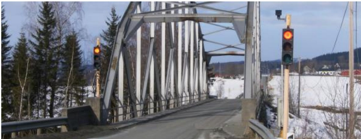
Figur 10: Bro over elven Forra (bilde tatt mot vest)
