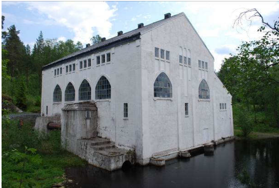
Figur 5.6. Kraftstasjonen Meråker I fra 1915
