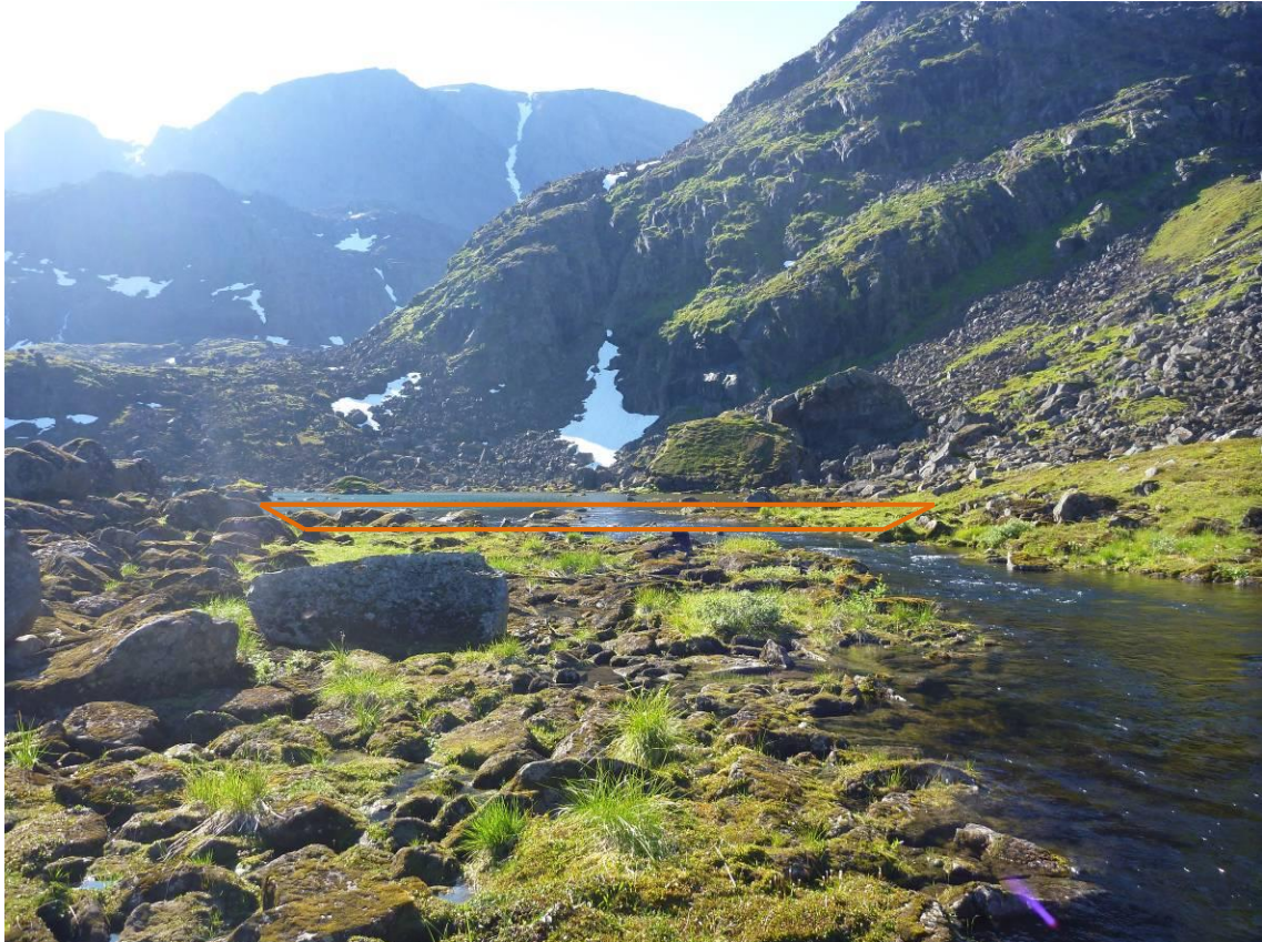
Bilde 3: Damsted ved utløpet av vatnet sett oppstrøms. Høyde på damkrone/fylling indikert.
