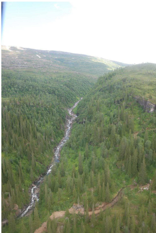
Bilde 5 - Eksisterende anleggsvei i området for rørgate.
