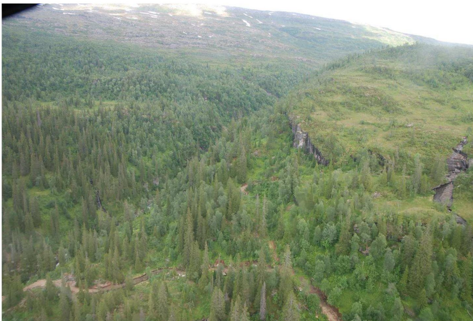
Bilde 4 – Eksisterende anleggsvei i området for rørgate.
