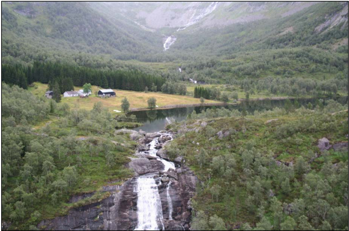
UTLØPET I LEIROVATNET. DET BLIR TERSKEL OVER ELVELØPET RETT FØR ELVA BRYTER NEDOVER. RØRGATEN FØRES NED PÅ HØYRE SIDE AVELVEN.
