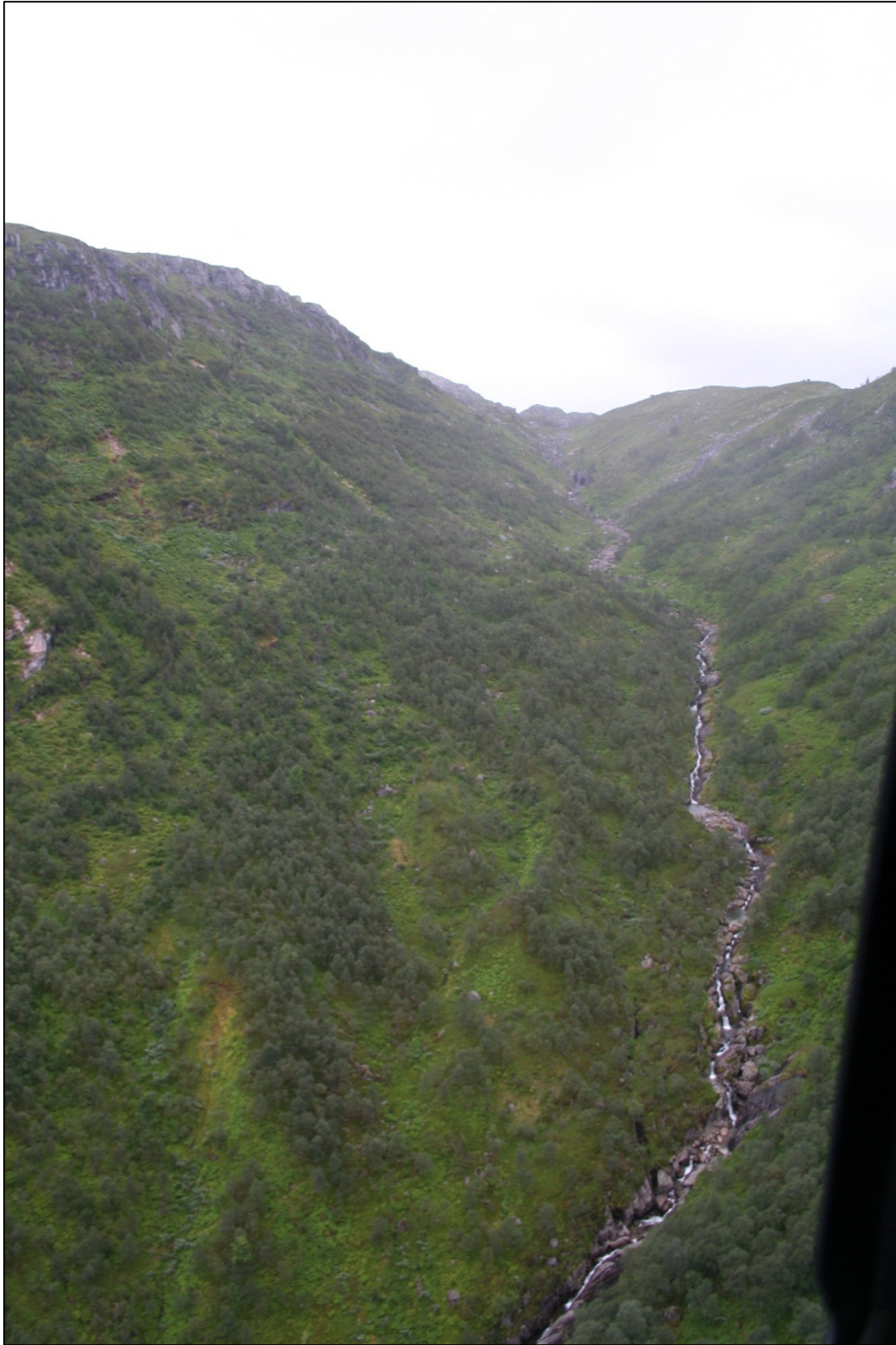
SETT OPPOVER ØVRE DEL AV STEINSEDALEN. RØRGATEN BLIR TIL VENSTRE FOR VANNSTRENGEN.
