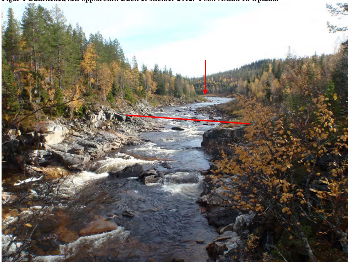
Figur 2 Inntaksbassenget, inntaket og dammen, sett nedstrøms. Inntaksbassenget vil gå opp til dit pilen viser. Dato: 3. oktober 2012. Foto: Åshild R. Opland.
