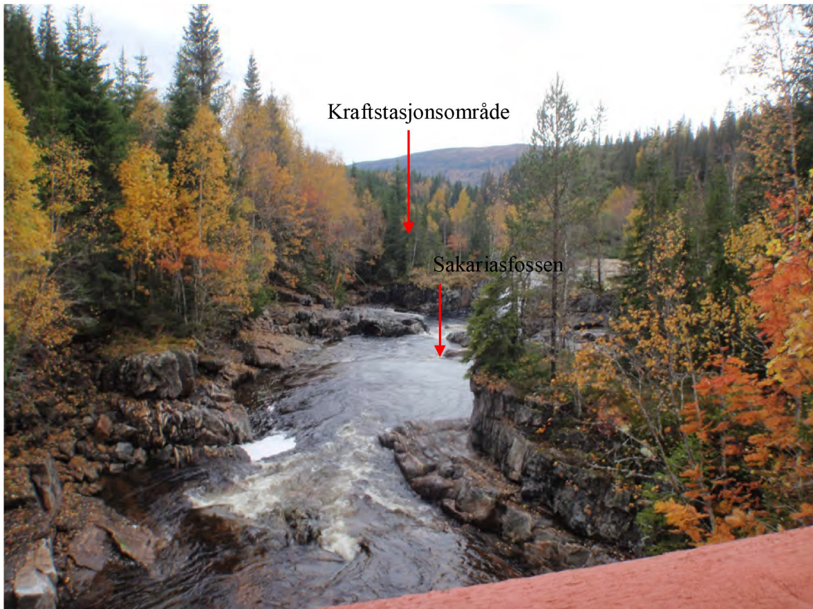
Figur 17 Sakariasfossen og kraftstasjonsområde. Bilde tatt fra bro over til Bekkaheimen. Dato: 3. oktober 2012. Foto: Åshild R. Opland.
