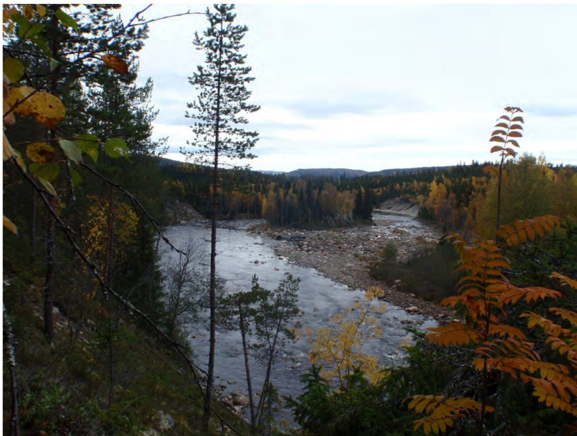
Figur 15 Grøndalselva, flatt område oppstrøms Sakariasfossen der det foregår erosjonssikring. Dato: 3. oktober 2012. Foto: Åshild R. Opland.
