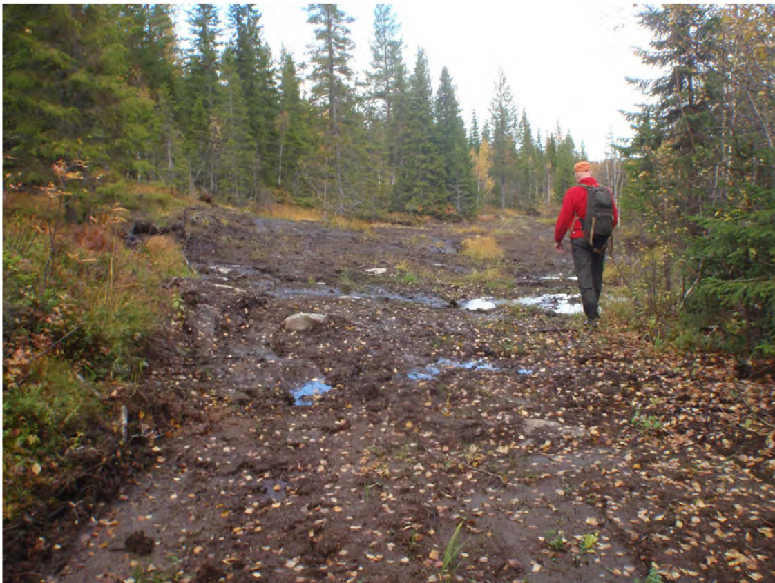
Figur 11 Eksisterende traktorvei på vestsiden av Grøndalselva bort til luftlinjene. Dato: 3. oktober 2012. Foto: Åshild R. Opland.
