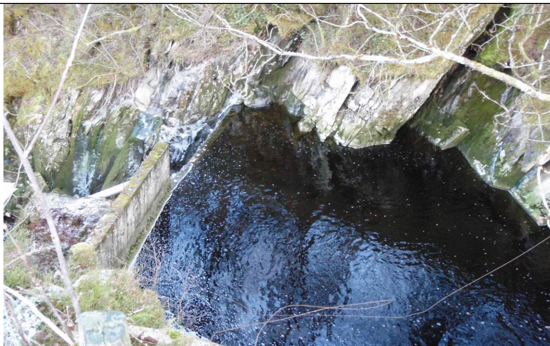
Bilete 1.5.1: Inntaksdam for vassforsyning til bustader i nærområdet og industri på vestsida av Ådlandsfjorden.
