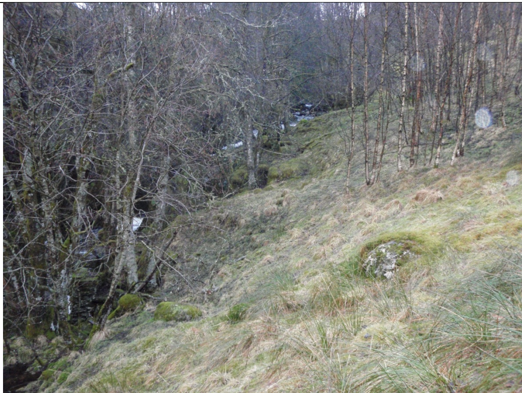
Matlandselva ved planlagt stasjonsplassering, vassføring = 0,52 m 3 /s
