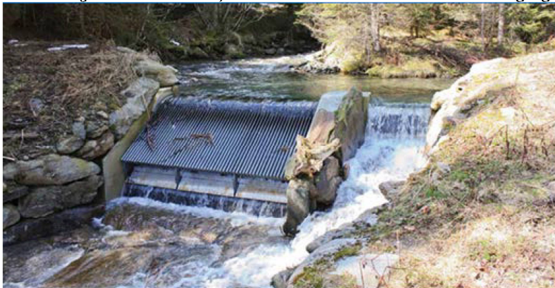
Figur 6: Døme på Coanda-inntak (frå konsekvensrapporten for Matlandselva).
