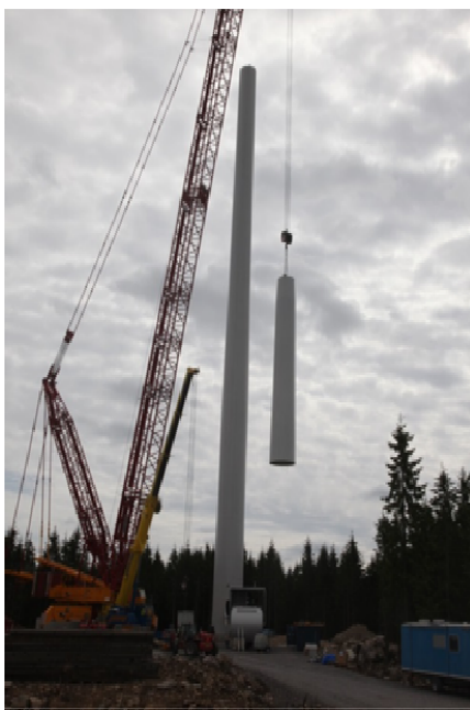
Figur 14 Montering av vindturbin.
