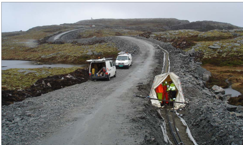
Figur 5 Eksempel på internt veinett med intern kabling langs veiskulder.
