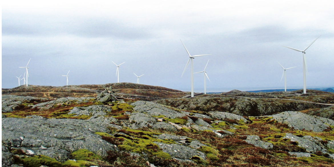
Figur 7. Eksempel på vindturbiner som kan være egnet for vindkraftprosjekt i Verdal. Tårnet i aktuelle vindturbiner er cirka 80-120 meter høyt og hvert vingebled er cirka 40-60 meter langt. Fotoet viser turbiner i Hitra vindkraftverk. (Foto: Sweco).
