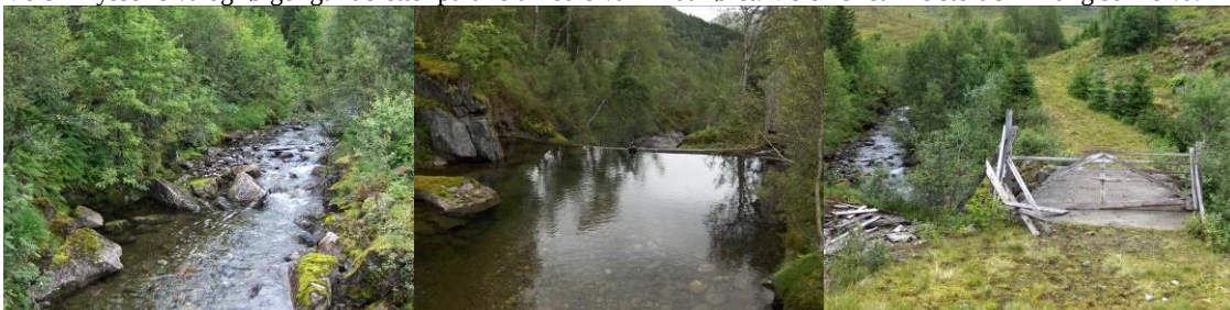
Nede ved kraftstasjonsområdet, en gammel terskel og ei bru.
