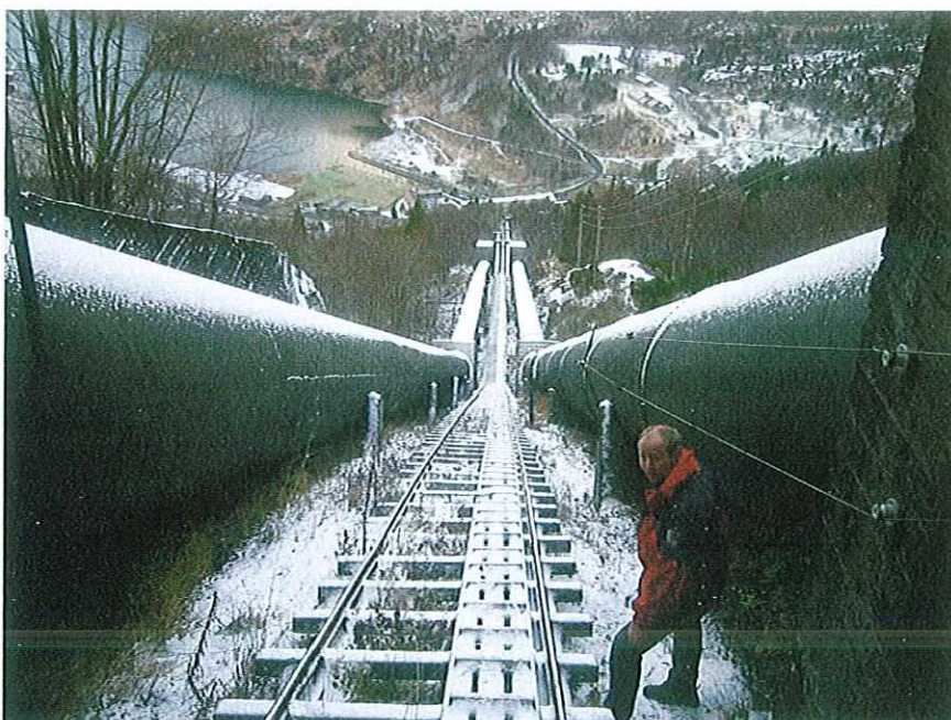
Figur 4 Rør og trallebane sett fra ventilkammeret. Til venstre rør på bildet 2, i midten trallebanen, til høyre rør 1.
