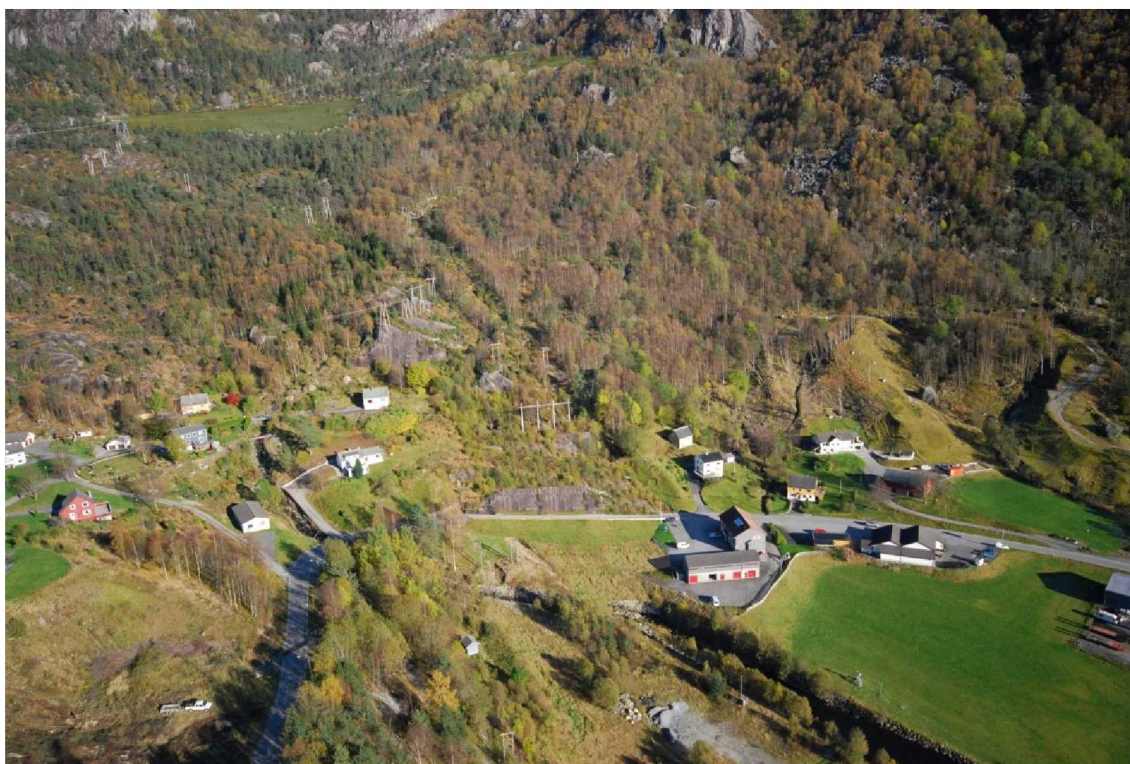
Figur 6: Blåfalli II etter nedlegging. Kraftstasjon og utløpskanal er gjenfylt, og veien vil gå på fylling i foten av fjellskjæringen bak kraftstasjonen. Rørgaten er fjernet. Tipp Skavdal gror etter hvert til. Visualisering: Einar Berg
