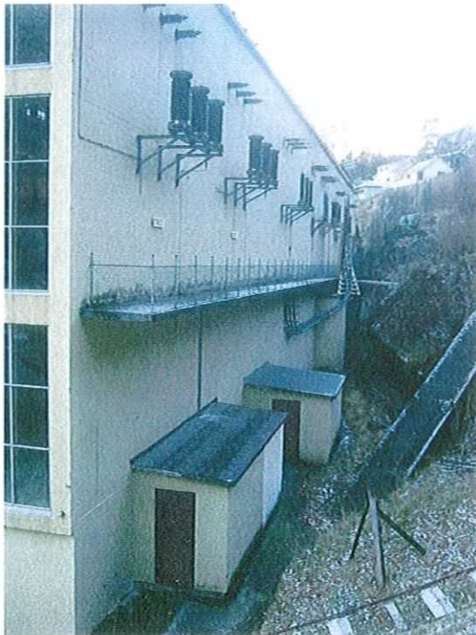
Strømgjennomføringer kan inneholde PCB. Strømgjennomføringer er EE-avfall.
