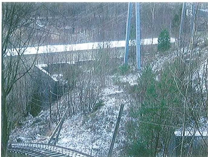
Figur 8 Mastefundamenter med forstøtningsmur
