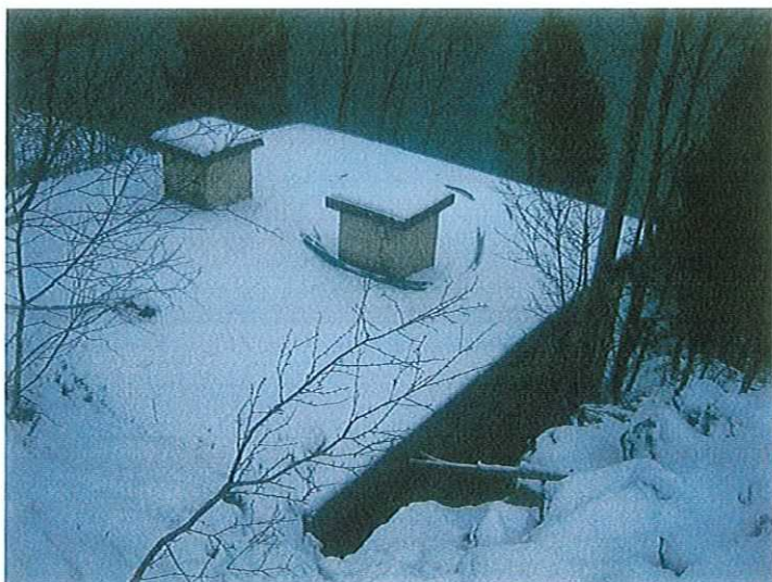
Figur 2 Lukehus sett ovenfra
