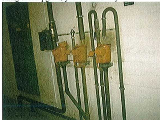
Rørisolasjon av cellegummi inneholder bromerte flammehemmere, her fra Blåfalli 2
