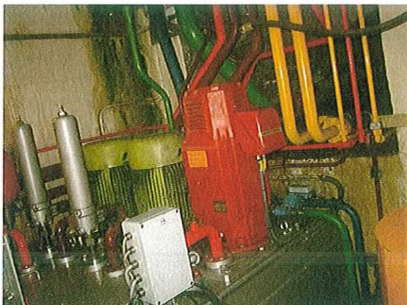
Hydraulikkoljeaggregat i blåfalli 1, med ca. 3000 liter olje.
