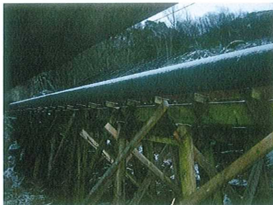
Trallebanen er bygd av både CCA-impregnert og kreosotimpregnert treverk.
