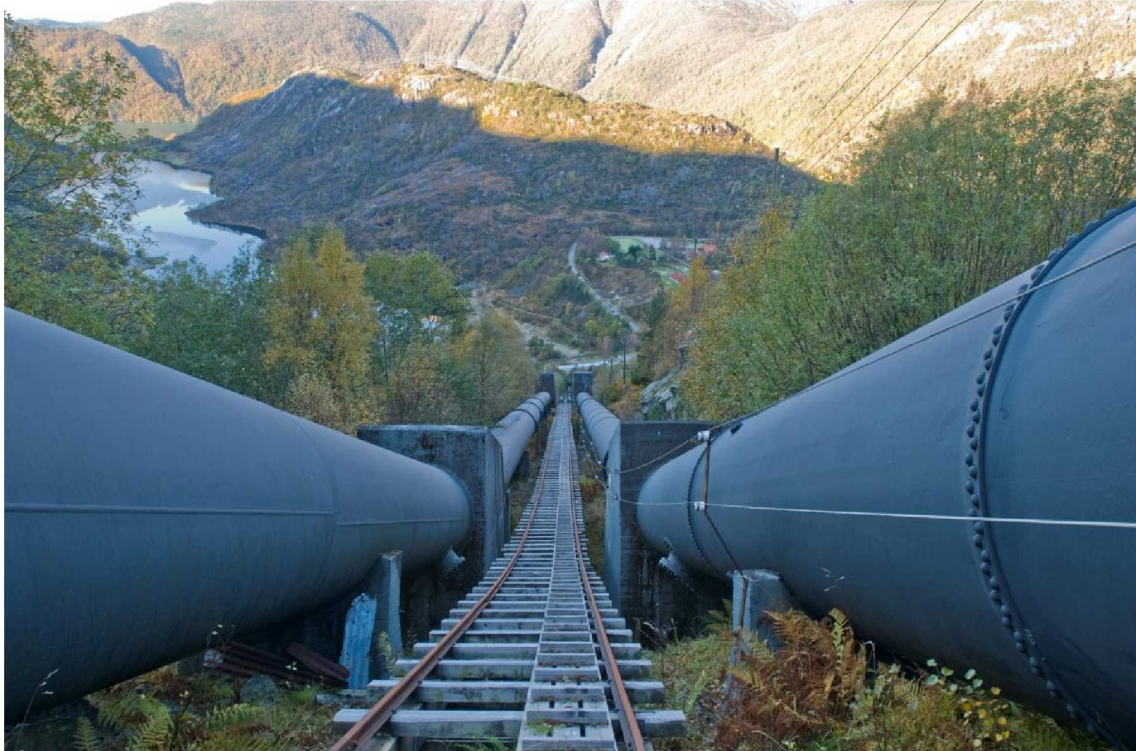
Figur 2: Rørgate med rørgatefundamenter og trallebane.
