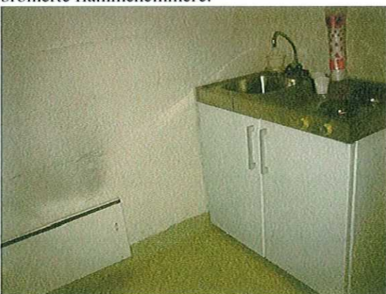
Minikjøkken i beredskapsrom i Blåfalli 1 har kjøleskap med HKFK-gass. Slike minikjøkken er EE-avfall.
