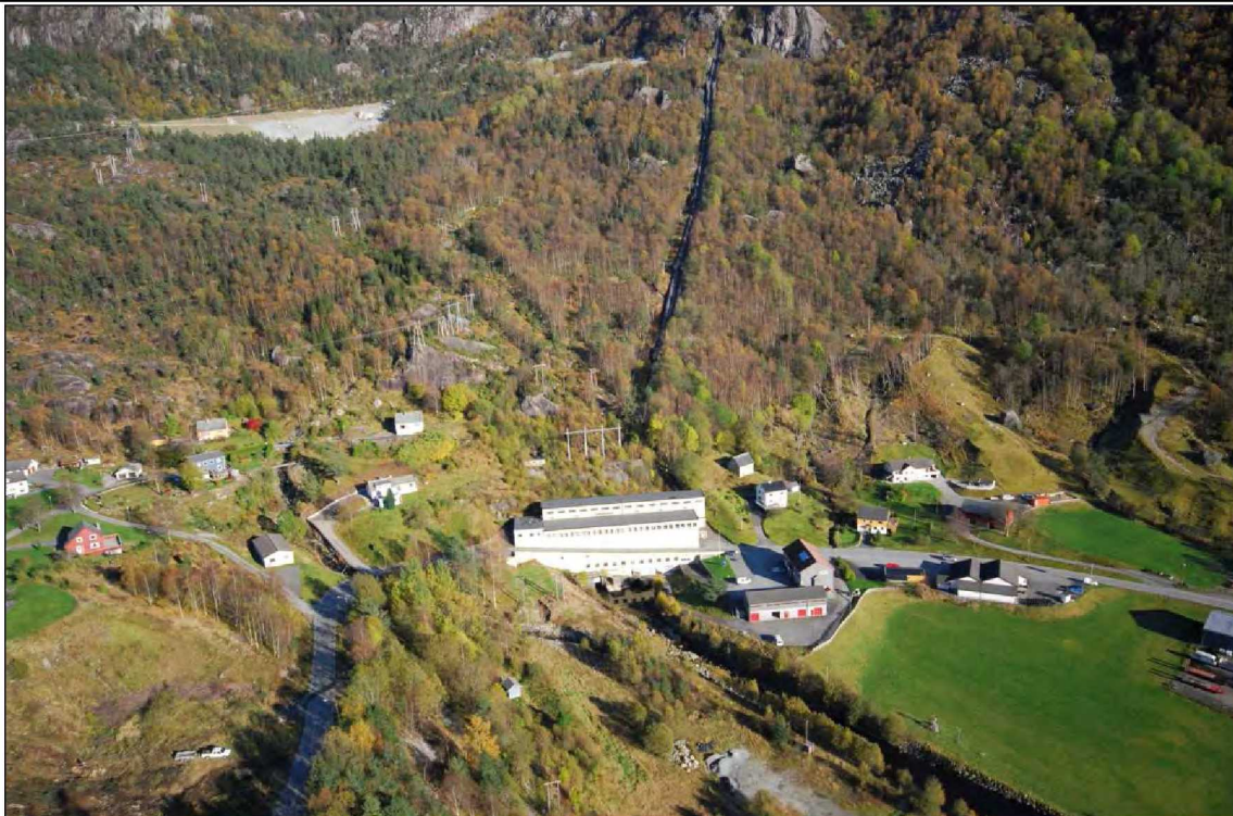
Bilete 4: Blåfalli II, rørgate, kanal og kjølevassbasseng før fjerning
