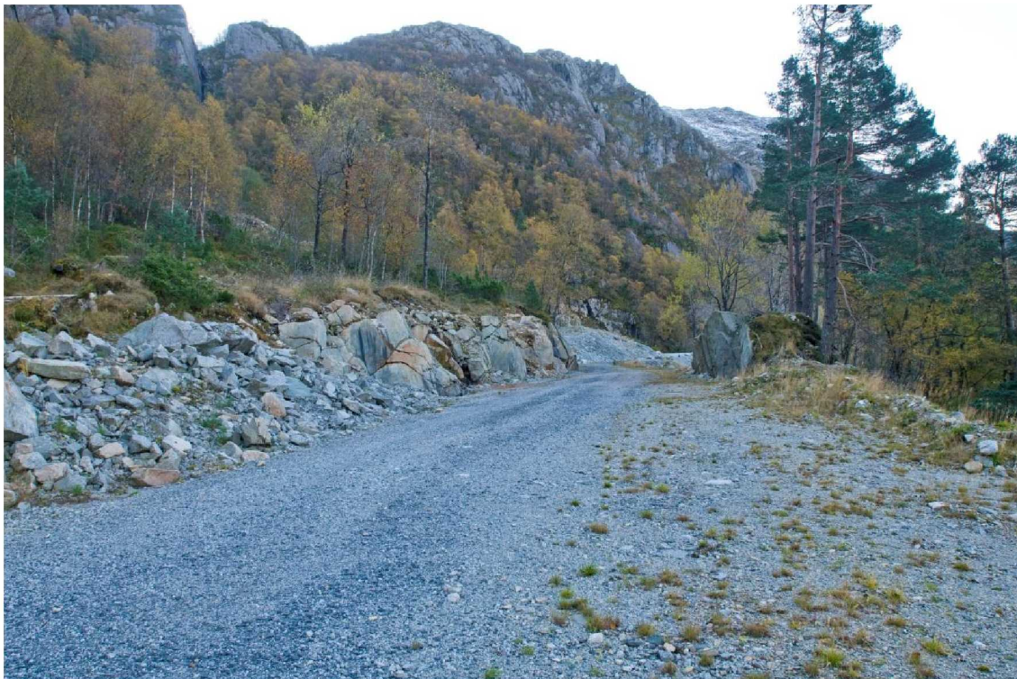
Figur 7: Skråningsstabilisering langs veien opp til tverrslag Skavdalen.
