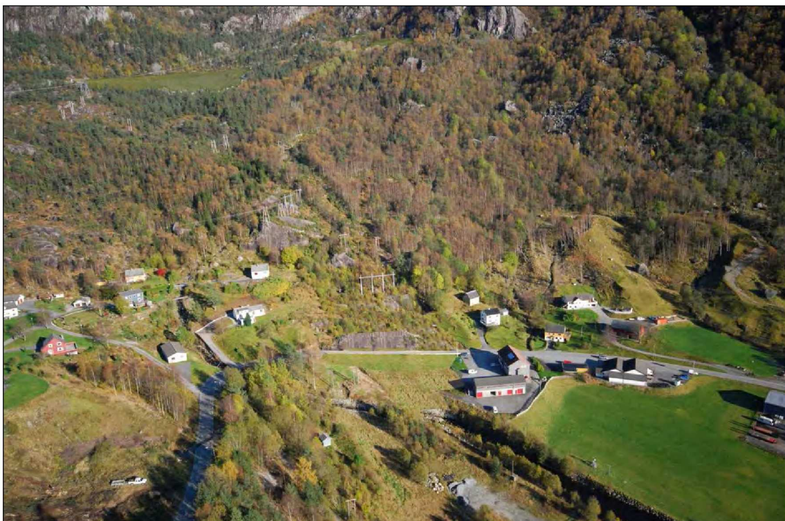
Bilete 5: Blåfalli II rørgate, kanal og kjølevassbasseng etter fjerning
