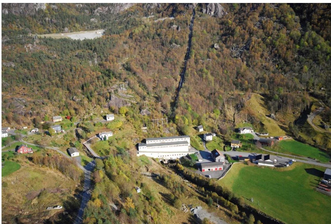
Figur 5: Blåfalli II med rørgate og kraftledninger. Tipp Skavdal oppe i lia. Dagens situasjon.
