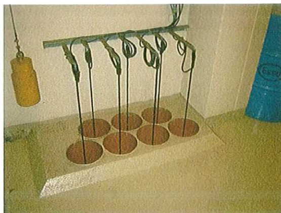
Nivåvipper i Blåfalli 1; 7 stk. Nivåvippene inneholder kvikksølv.
