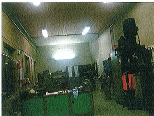
De fleste lysrørarmaturer i byningene er skiftet ut med nye. I enkeltrom kan det imidlertid finnes gamle lysrørarmaturer med PCB-holdig kondensator. Alle lysrørarmaturer er EE-avfall.
