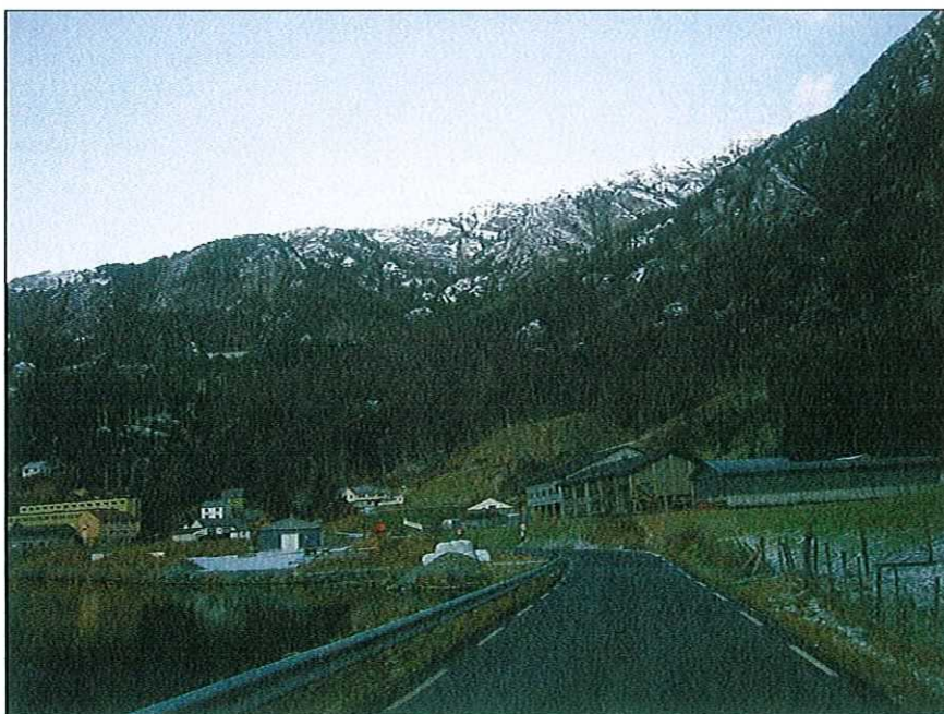
Figur 18 Oversiktsbilde av rørtraséen. Den gulmalte kraftstasjonen Blåfalli 2 sees i nedre venstre hjørne.
