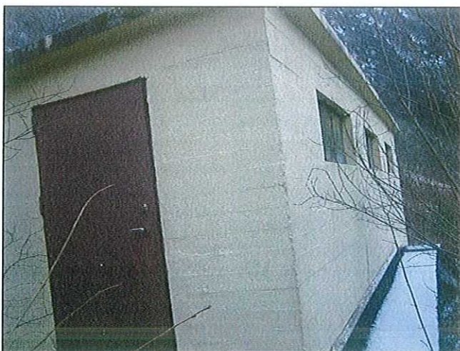
Figur 7 Hus over kjølevannsbasseng
