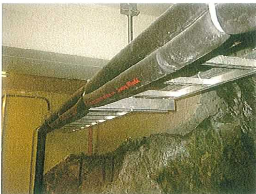
Rørisolasjon av cellegummi inneholder bromerte flammehemmere, her fra Blåfalli 1
