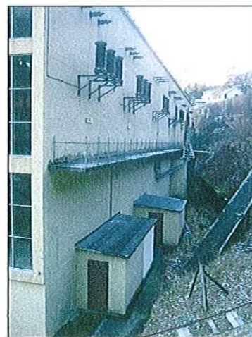
Strømgjennomføringene sett fra utsiden av bygningen.
