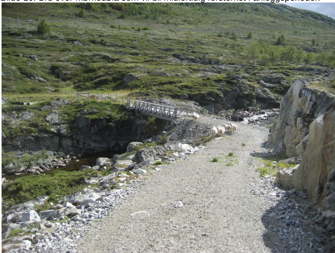
Bilde 10: Bru over Mørkedøla som vil bli midlertidig forsterket i anleggsperioden
