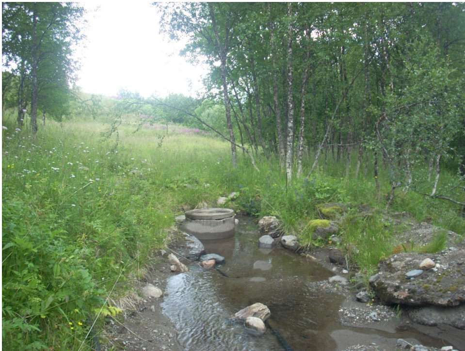
Figur 17: Vanninntak/kum lokalisert få meter oppstrøms planlagt kraftstasjon. Foto: Ole Roer
