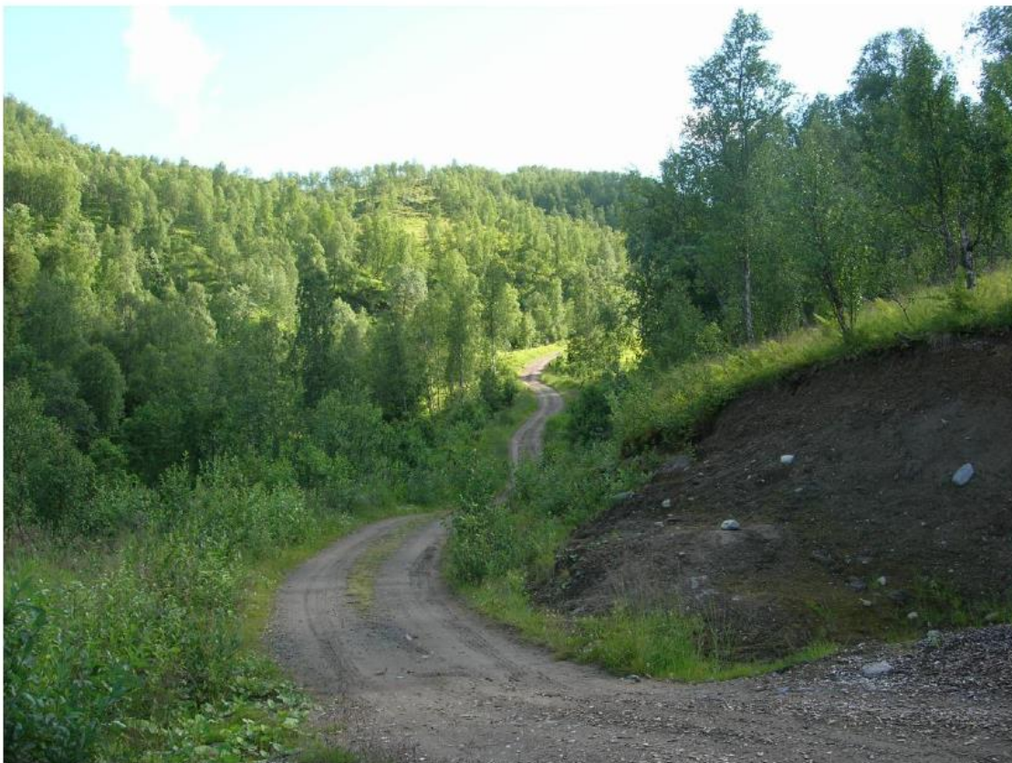
Rørtrasé sett oppstrøms. Rørgata vil ligge på venstre side av veien oppover.
