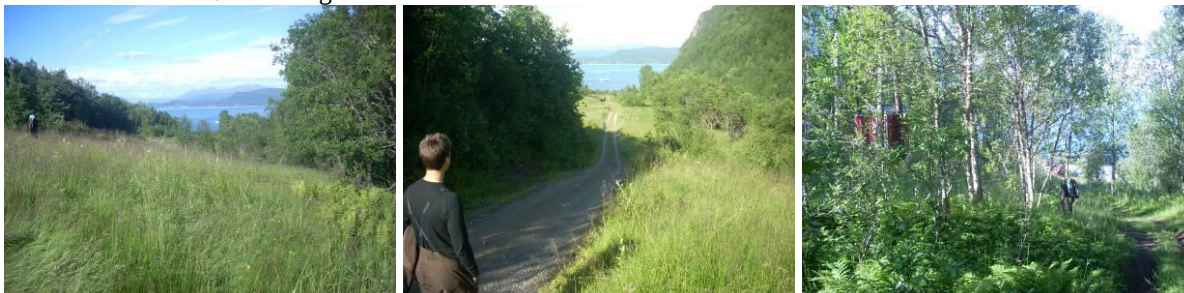
Bildene over viser partier fra nedre del av rørgata, med trafo for nett tilkøpling på bildet til høyre.
