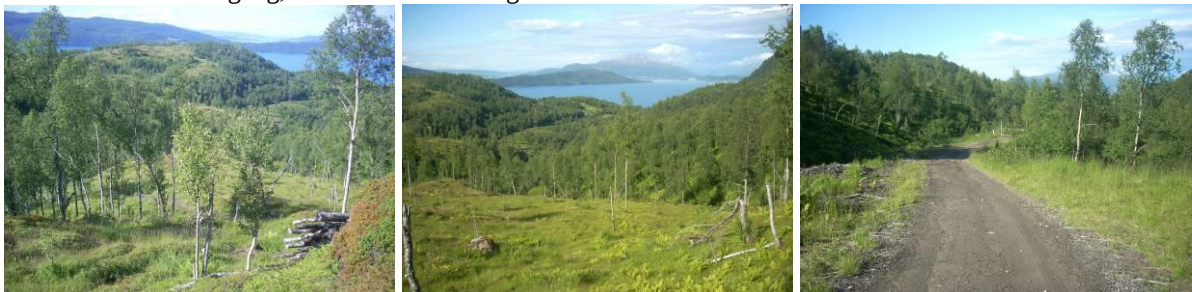
Bildene over viser utdrag av rørgata ned til der den kommer inn på eksisterende bilvei.
