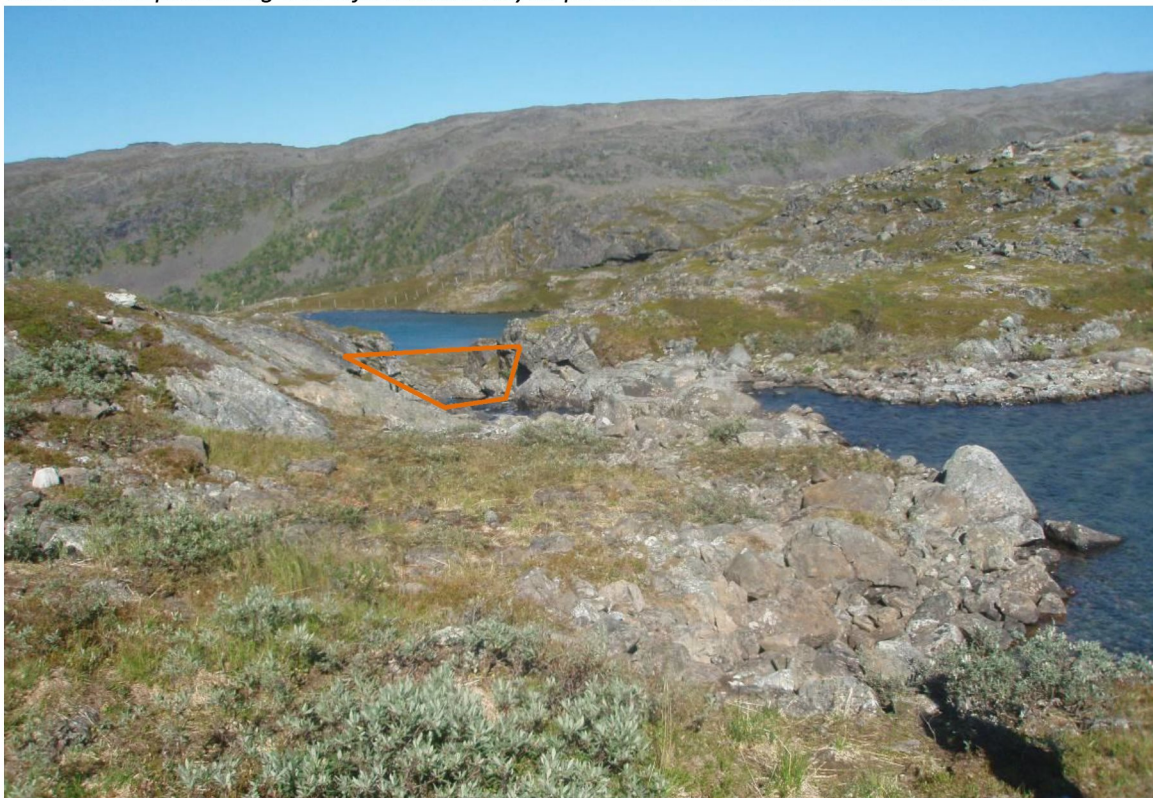
Bilde 1: Dam plassering ved Stjernevatn. Høyde på damkronen indikert ved kote 328
