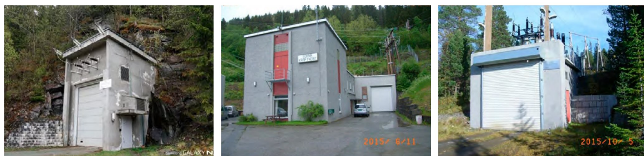
Figur 3 : Sama, Håen og Sokna kraftverk.
