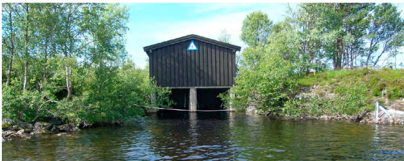
Figur 4 : Inntak Holtsjøen, overføring til Samsjøen
