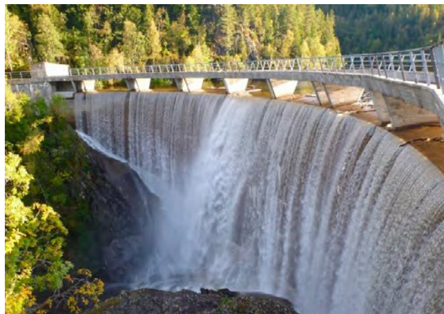
Figur 10 : Overløp inntak Sokna
