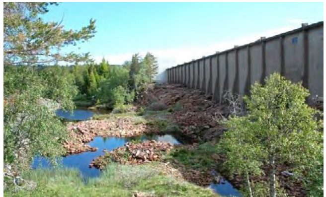
Figur 7 : Overløpsterskel dam Håen
