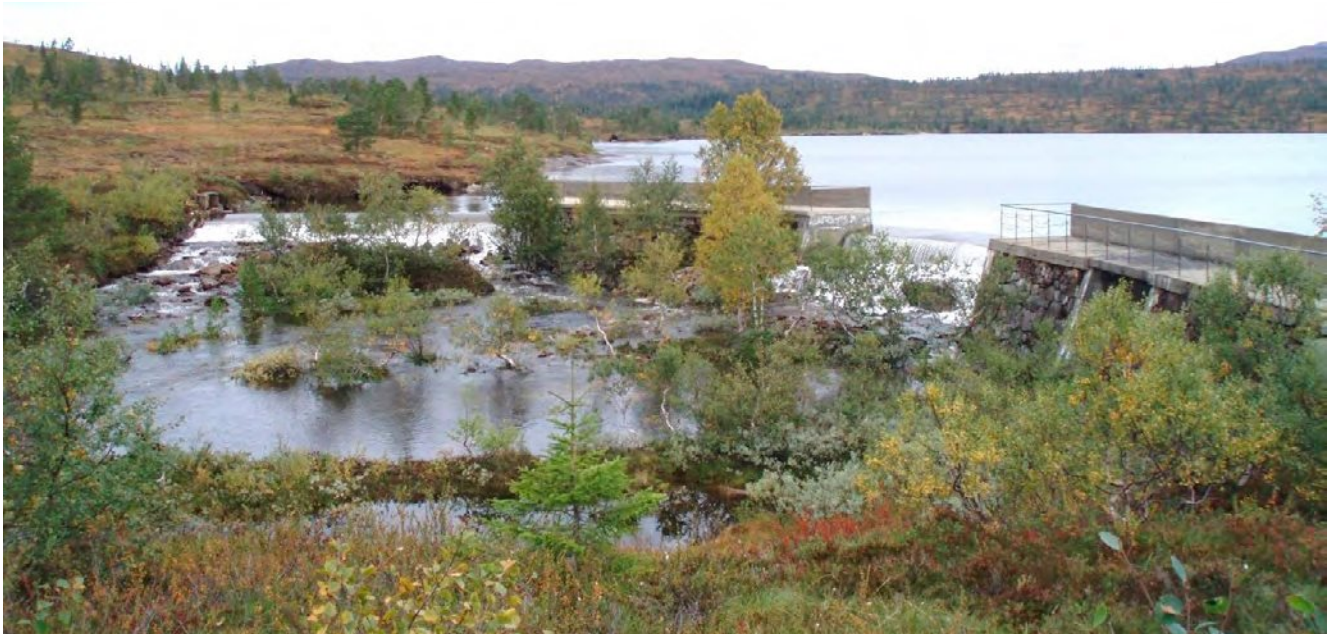
Figur 5 : Dam Samsjøen ved overløp.
